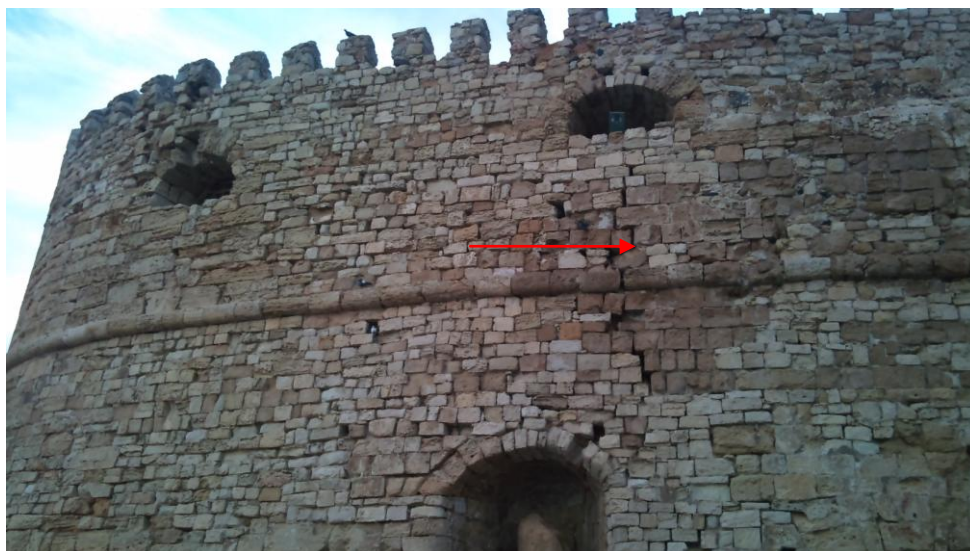
Εικ.10 : Εξωτερική άποψη στο νοτιοανατολικό τμήμα με την κατακόρυφη διαμπερή ρωγμή
