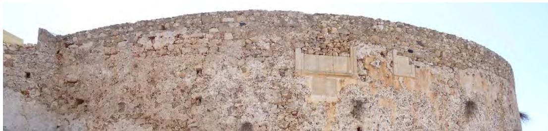
Εικόνα 3.17: Άποψη της κορυφογραμμής του πύργου στη ΒΑ όψη. Διακρίνονται οι θέσεις των οικοσμήμων και η διαφοροποίηση της λιθοδομής του στηθαίου.
