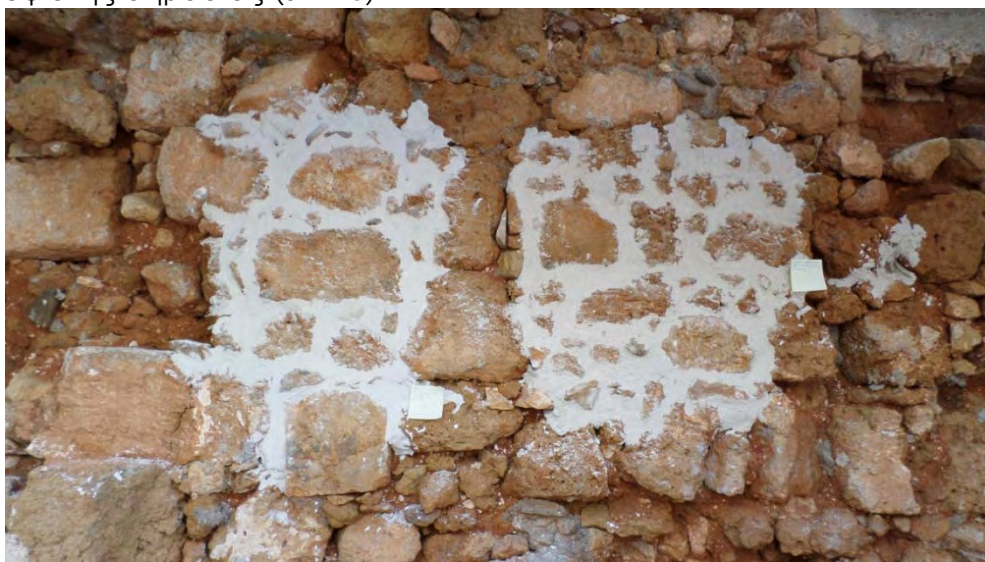
Εικόνα 2.3: Βαθύ αρμολόγημα σε αργολιθοδομή. (Παλιά Πόλη, Χανιά 2013)
