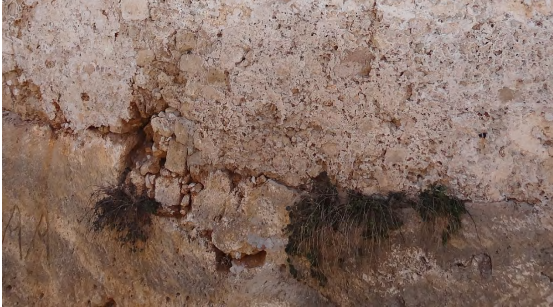
Εικόνα 3.19: Σημειική διάρρηξη υλικού και συνοχής βράχου-τοιχοποιίας.
