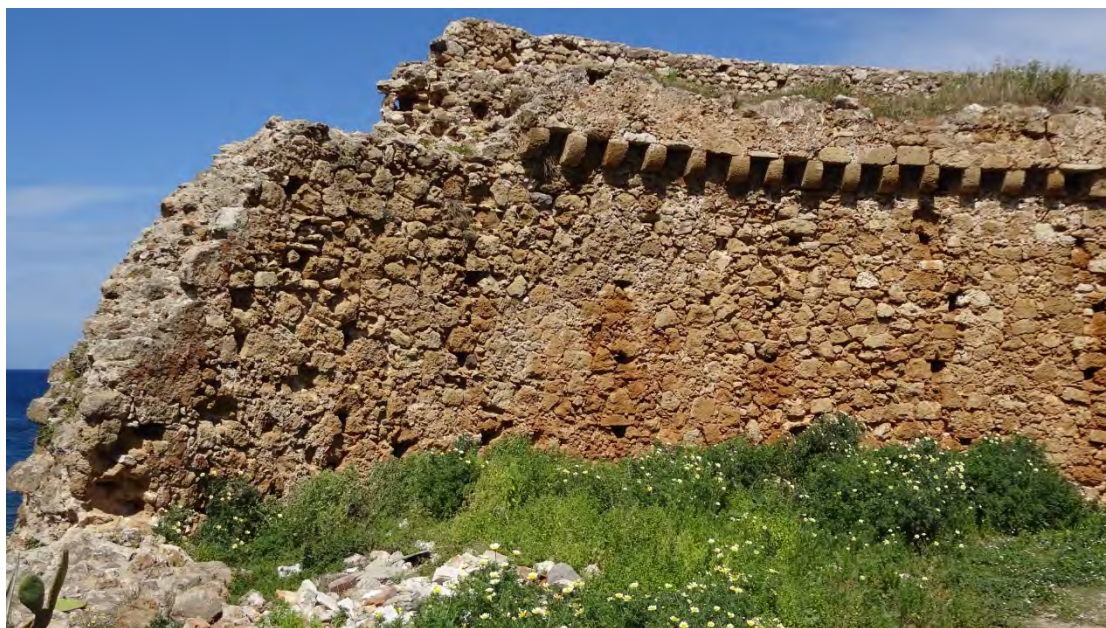
Εικόνα 3.12: Το στηθαίο στη κορυφή και το πέτρινο παραπέτο με τα φουρούσια.
