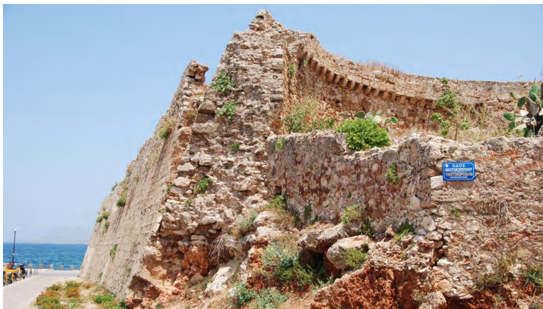
Εικόνα 3.13: Ορατή τομή. Scarpa σημείου χαμηλότερης θεμελίωσης στο βράχο.
