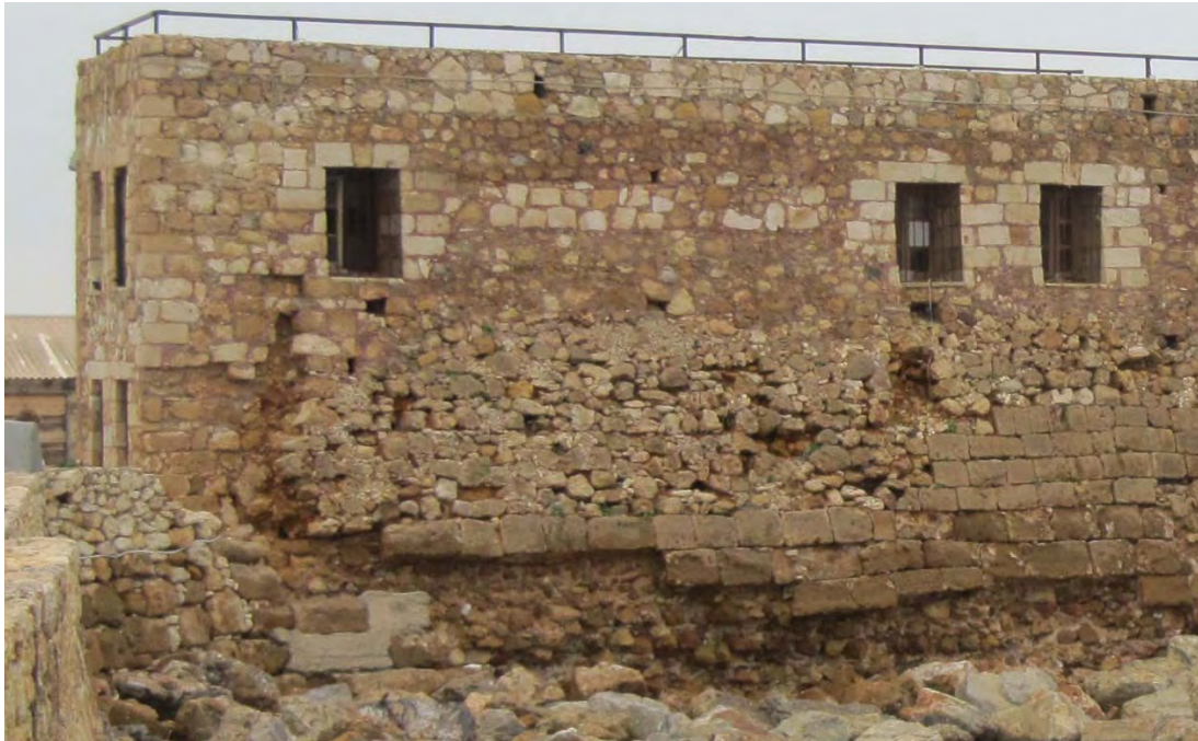
Εικόνα 2.1: Κατάρρευση εξωτερικής στρώσης τοιχοποιίας (Fortezza Χανίων).
