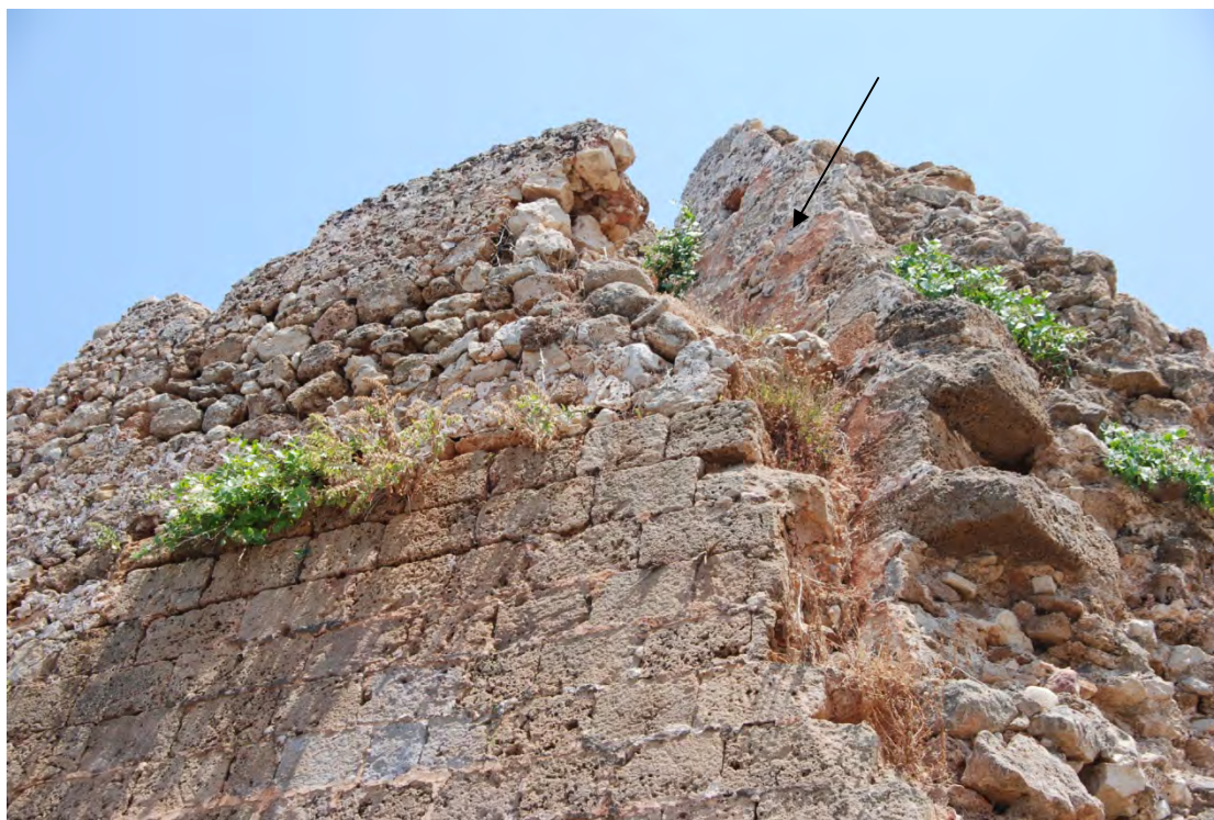
Εικόνα 3.16: Ισόδομο σύστημα στο εναπομείναν κεκλιμένο τμήμα της τοιχοποιίας.
