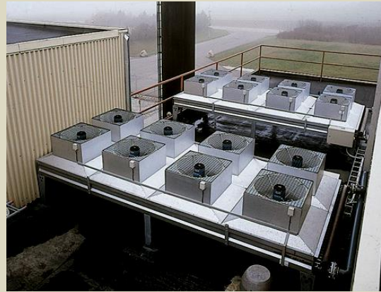
Εικόνα 25: Dry Coolers
