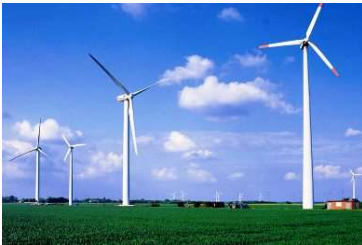
Σχήμα 86 Ανεμογεννήτριες με χαλύβδινους σωληνοειδείς πύργους
