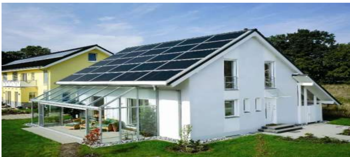
Σχήμα 60 Απευθείας τοποθέτηση φωτοβολταϊκών σε κτίριο
