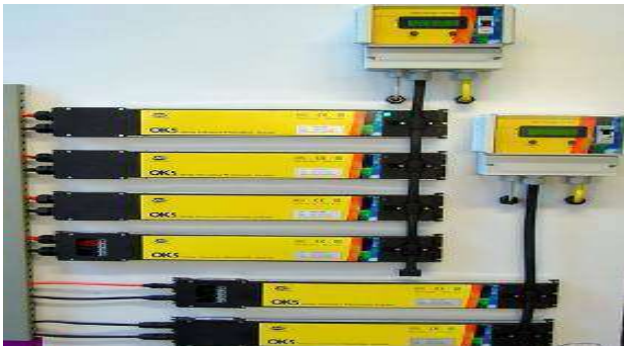
Σχήμα 51 Αντιστροφέας για ενσωμάτωση σε Φ/Β πάνελ [38]
