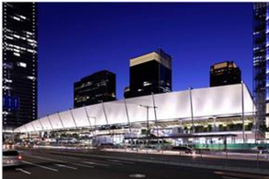
Εικόνα 12: Εφαρμογή υπερυδρόφιλων επικαλύψεων \text{TiO}_2 στο στέγαστρο του σταθμού στο Τόκιο, φωτοκαταλυτική μεμβράνη της εταιρείας Taiyo Kogyo Corporation [62].
