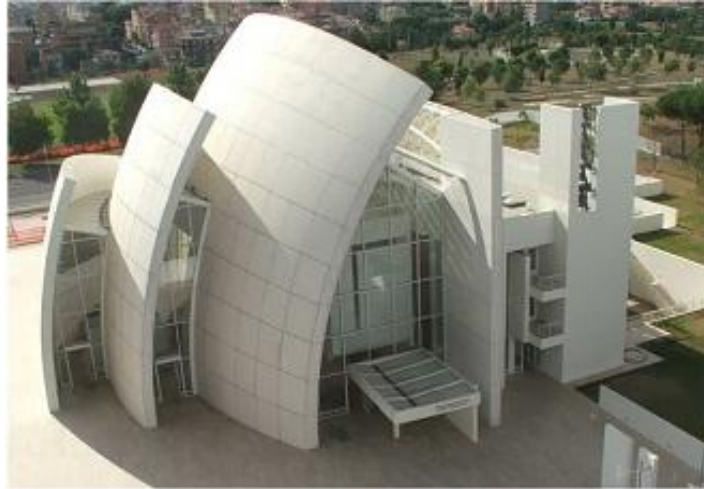
Εικόνα 7: Φωτογραφία της καθολικής εκκλησίας Dives in Misericordia της Ρώμης. Δείγμα εφαρμογής της φωτοκαταλυτικής τεχνολογίας σε δομικά υλικά [53].
