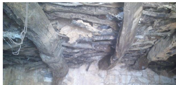
Εικ.80. Τα δοκάρια από κορμούς δέντρου.
