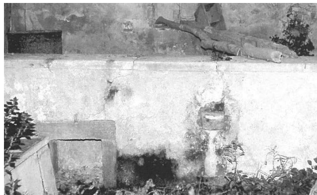
Εικ.59. Το πατητήρι στο Χρ. Ρασιδάκη στα Πεζά, με θυρίδα πίσω και δοκούς στήριξης των ληνοβατών.
