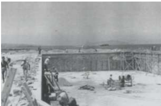
Εικόνα 44: Κατασκευή της «ολυμπιακών διαστάσεων», 20x50μ., κολυμβητικής δεξαμενής του Ν.Ο.Χ., Αρχείο Χρ. Χουλιόπουλου (Πηγή: Η αλίβρεκτος Νέα Χώρα)
