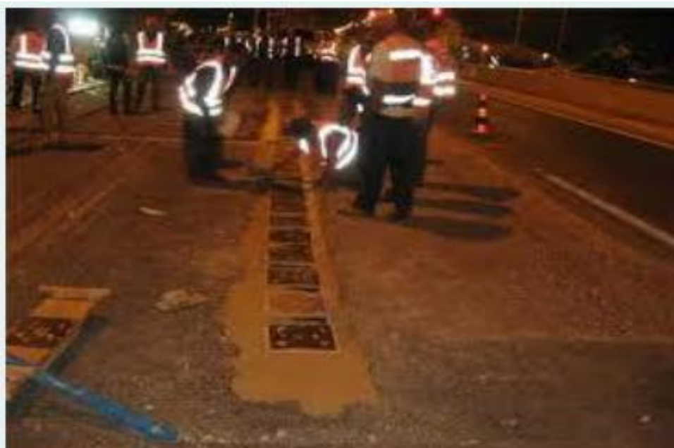
Εικόνα 2.4: Μετατροπή της ενέργειας από τα διερχόμενα οχήματα σε ηλεκτρισμό
