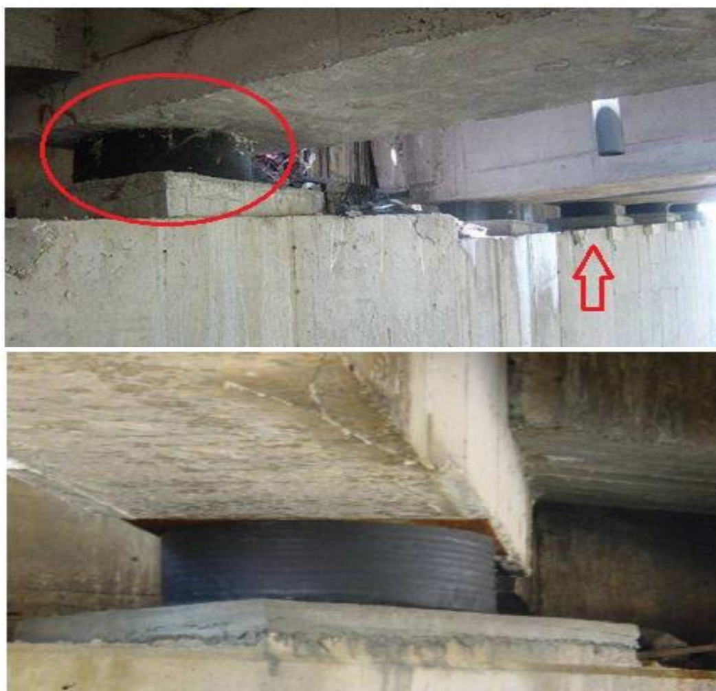
Εικόνα 2.13: Θέση εφεδράνου σε μια γέφυρα
