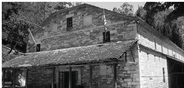
Εικ.167 Ξύλινη κατασκευή με πλάκες σε πηλειορίτικη εκκλησία
