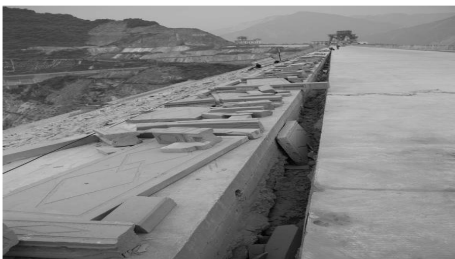
Εικόνα 3.7. Επιμήκης διάρρηξη στο αριστερό πρηνές του άξονα του φράγματος (Πηγή: Λέκκας, 2008)
