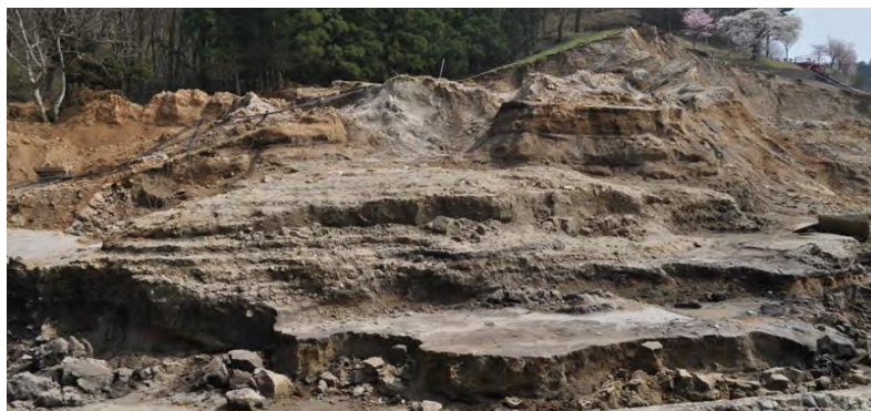
Εικόνα 3.15. Αστοχία στο δεξιό αντέρεισμα του φράγματος Fujinuma (Πηγή: Pradel et al., 2013)
