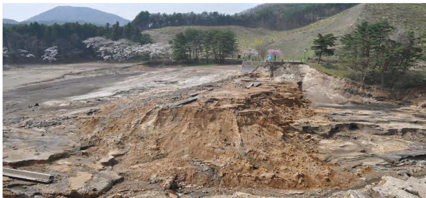
Εικόνα 3.12. Αστοχία που προκλήθηκε στο κύριο φράγμα Fujinuma και του ταμιευτήρα του (Πηγή: Pradel et al., 2013)
