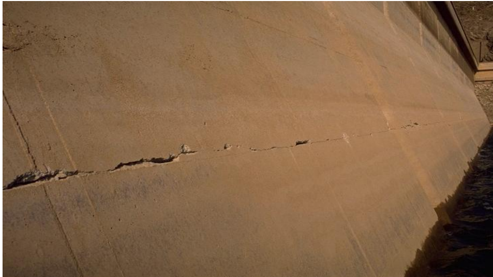
Εικόνα 3.19. Οριζόντια ρωγμή στο φράγμα Sefid Rud (Πηγή: Wieland, 2009).
