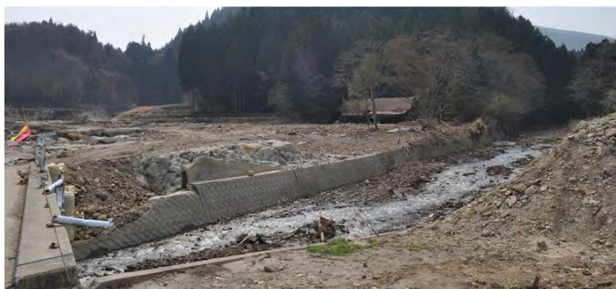
Εικόνα 3.13. Ζημιές που προκλήθηκαν στο χωριό Naganuma από την πλημμύρα λόγω της ανεξέλεγκτης απελευθέρωσης του νερού από το φράγμα Fujinuma (Πηγή: Pradel et al., 2013)
