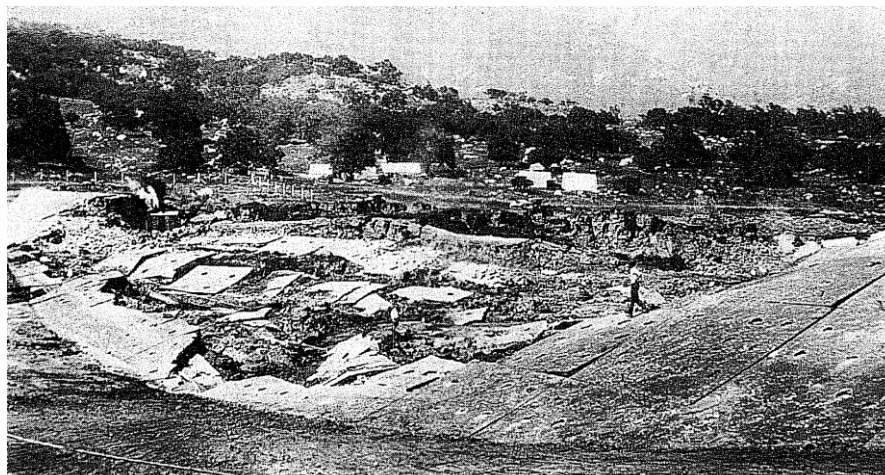
Εικόνα 2.6. Ρευστοποίηση στο φράγμα του Σεφιλντ (Πηγή: Kramer, 1996).
