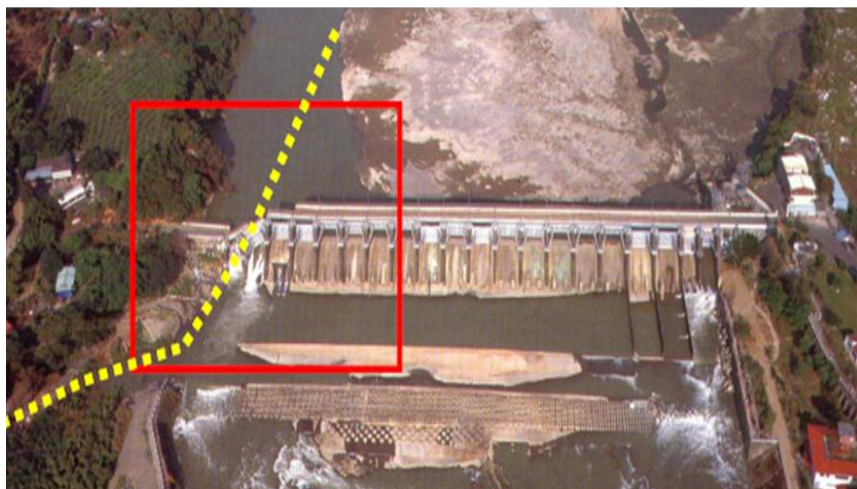
Εικόνα 3.31. Αστοχία του φράγματος Shih-Kang εξαιτίας του σεισμού Chi-Chi (Πηγή: Tsompanakis et al., 2013).
