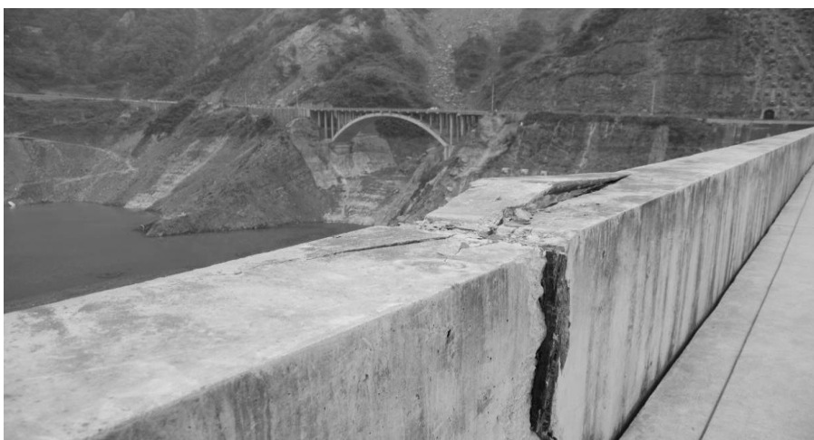
Εικόνα 3.5. Αστοχία στη στέψη του φράγματος (Πηγή: Λέκκας, 2008)
