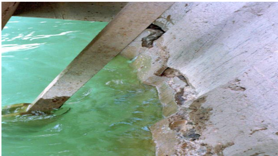
Εικόνα 3.20. Αστοχία στους συνδέσμους στήριξης του φράγματος Sefid Rud (Πηγή: Wieland, 2009).
