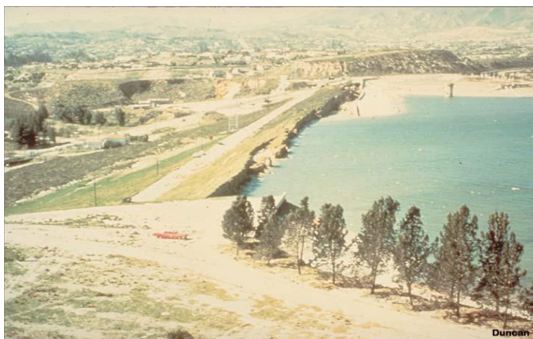
Εικόνα 3.37. Γενική όψη του φράγματος San Fernando με εμφανή την ολίσθηση (Πηγή: http://www.geo-slope.com/ )
