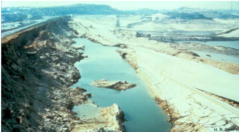
Εικόνα 3.36. Αστοχία στα ανάντη του φράγματος San Fernando (Πηγή: http://www.geo-slope.com/ )
