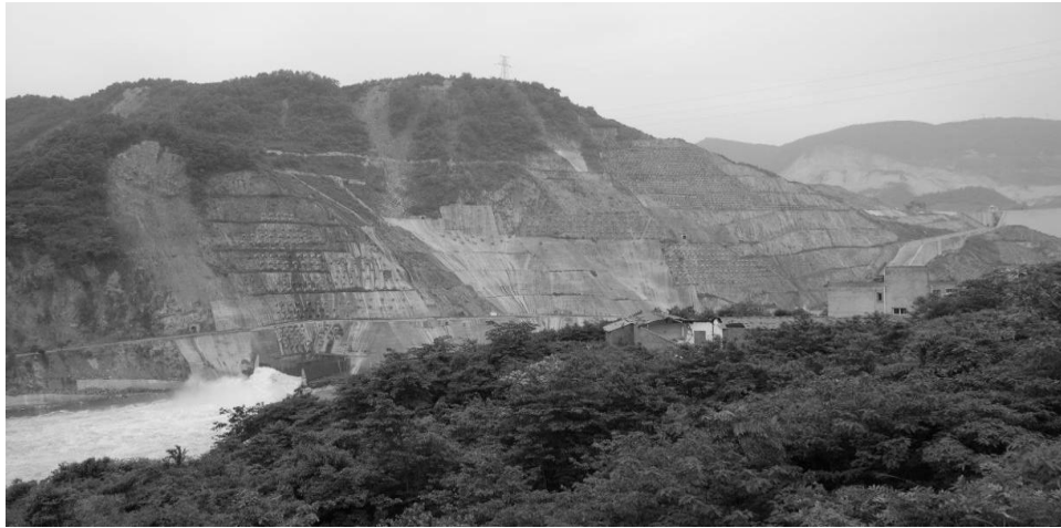
Εικόνα 3.9. Κατολισθήσεις και έργα σταθεροποίησης των πρανών στο δεξιό πρανές (Πηγή: Λέκκας, 2008)
