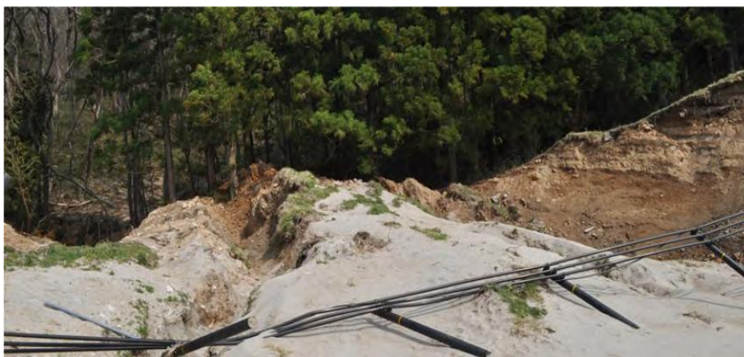
Εικόνα 3.16. Εκτοπισμένοι λίθοι κατά μήκος του δεξιού αντερείσματος του φράγματος (Πηγή: Pradel et al., 2013)
