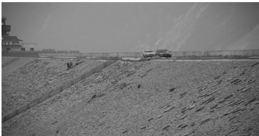
Εικόνα 3.6. Καθίζηση του πυρήνα του φράγματος και κατολισθήσεις που αναπτύχθηκαν στο πρηνές της λεκάνης κατάκλυσης (Πηγή: Λέκκας, 2008)
