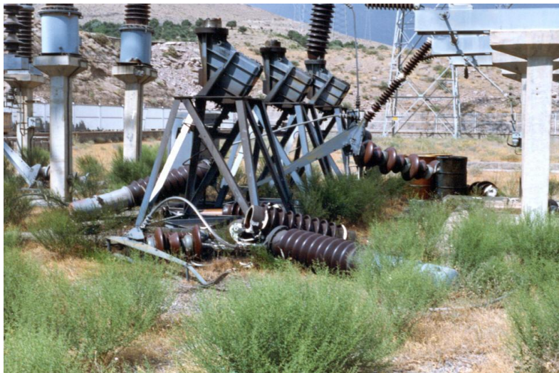
Εικόνα 3.22. Βλάβες στα συστήματα διανομής του φράγματος Sefid Rud (Πηγή: Wieland, 2009).
