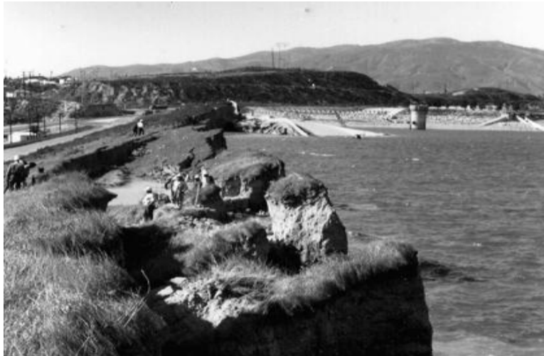
Εικόνα 3.35. Τοίχωμα που παρέμεινε στο φράγμα του San Fernando (Πηγή: http://earthquake.usgs.gov/learn/publications/la-damstory/ ).
