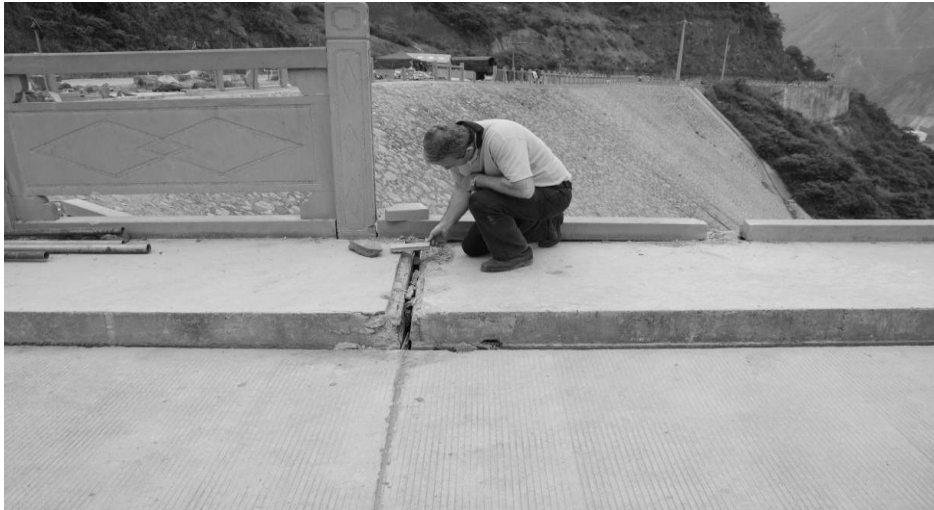
Εικόνα 3.3. Κατακόρυφη μετατόπιση στο αριστερό τμήμα του σώματος του φράγματος (Πηγή: Λέκκας, 2008)
