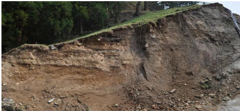
Εικόνα 3.14. Αστοχία στις πλαγιές του φράγματος Fujinuma (Πηγή: Pradel et al., 2013)
