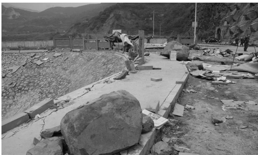
Εικόνα 3.8. Κατολισθήσεις βραχωδών όγκων στο αριστερό πρανές πάνω στη στέψη του φράγματος (Πηγή: Λέκκας, 2008)
