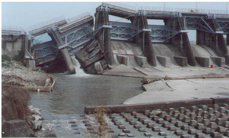
Εικόνα 3.29. Αστοχία στους υπερχειλιστές του φράγματος Shih-Kang (Πηγή: Wieland, 2009).
