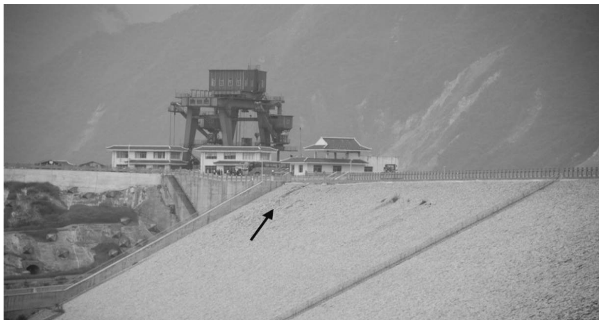
Εικόνα 3.4. Εγκάρσιες θραύσεις στο δεξιό άκρο του σώματος του φράγματος (Πηγή: Λέκκας, 2008)
