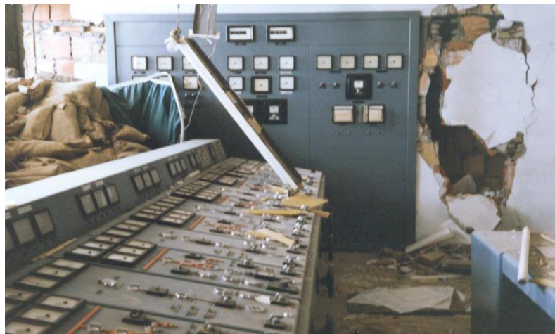
Εικόνα 3.21. Βλάβες στο κέντρο ελέγχου του φράγματος Sefid Rud (Πηγή: Wieland, 2009).
