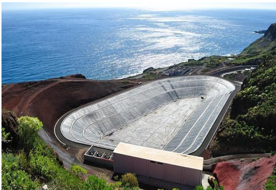
Εικόνα 3. Διαδικασία εγκατάστασης γεωμεμβράνης στον κάτω ταμιευτήρα του υβριδικού έργου στο νησί El Hierro. (ABC ESPANA, 2013)
