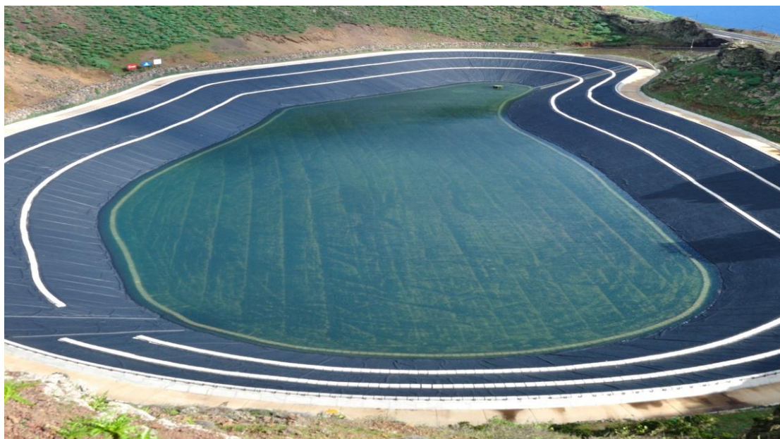
Εικόνα 4. Ολοκλήρωση εγκατάστασης γεωμεμβράνης και σταδιακή πλήρωση του άνω ταμιευτήρα του υβριδικού έργου στο νησί El Hierro. (www.managenergy.net, 2014)
