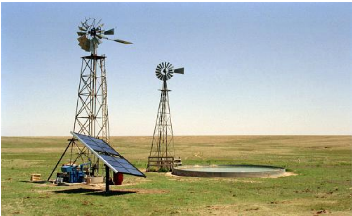
Εικόνα 16. Εφαρμογή υβριδικής τεχνολογίας άντλησης Α/Γ-Φ/Β στο πεδίο. (www.oksolar.com, 2014)
