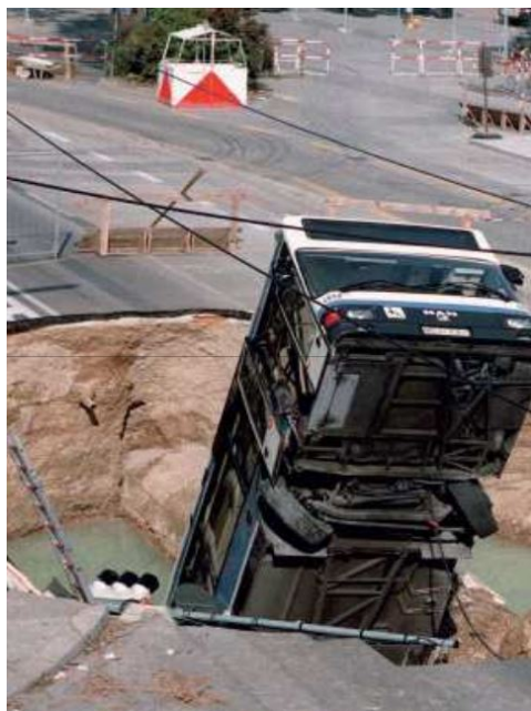
Σχήμα 1.11: Εμφάνιση επιφανειακού κρατήρα λόγω κατάρρευσης του μετώπου μίας σήραγγας κατά την φάση της εκσκαφής με τη μέθοδο NATM για τον υπόγειο του Μονάχου (27 Σεπτ. 1994).
