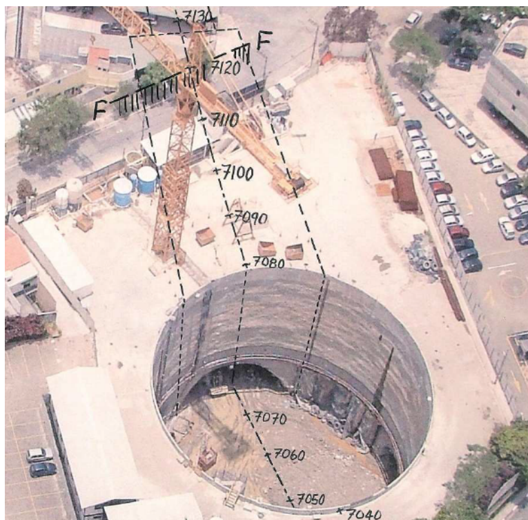
Σχήμα 2.11: Αεροφωτογραφία του φρέατος στο σταθμό του Pinheiros. Η αρχή της σήραγγας, η χιλιομετρική θέση 7080 και η ασυνέχεια (FF) που φαίνεται στο βάθος, στη χιλιομετρική θέση 7120, οριοθετούν την 40m περιοχή κατάρρευσης του σταθμού (Barton, 2009).
