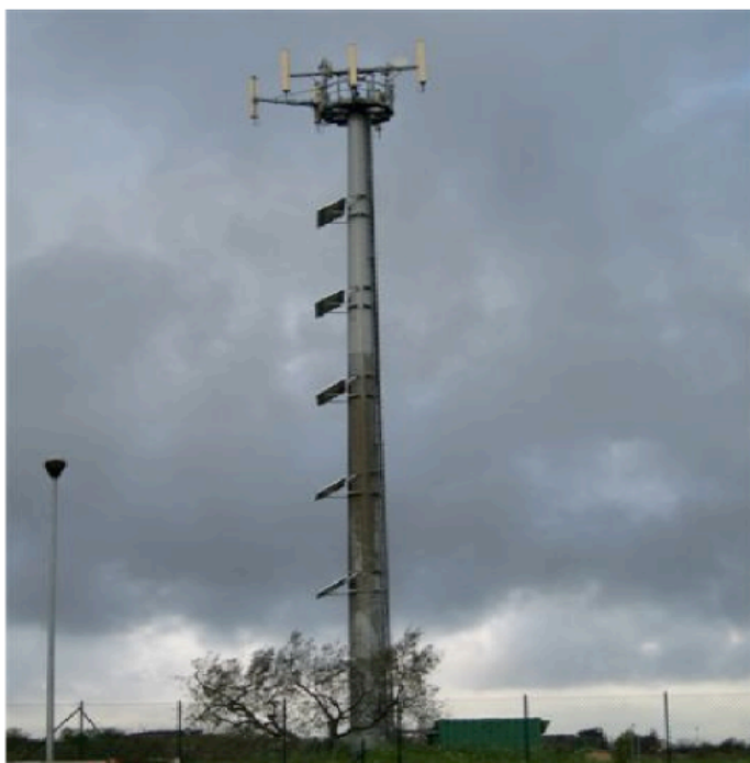
Σχ. 2.15 Φωτοβολταϊκά σε σταθμό βάσης (Vodafone-Italia) [20]
