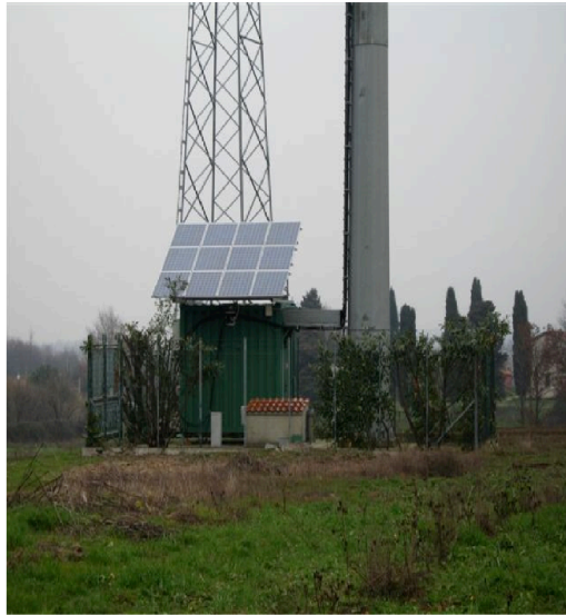
Σχ. 2.14 Φωτοβολταϊκά σε σταθμό βάσης (Vodafone-Italia ) [20]
