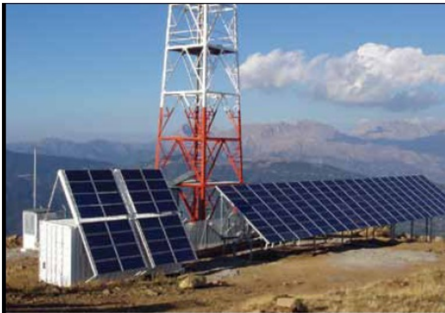
Σχ. 2.16 Φωτοβολταϊκά σε σταθμό βάσης (Sunlight) [21]
