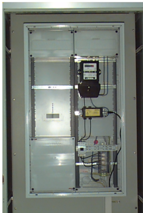
Σχήμα 4.2. Συσκευή που ξεχωρίζει ηλεκτρικό σήμα/σήμα πληροφορίας για τη μεταφορά δεδομένων μέσω δικτύου ηλεκτρικής ενέργειας [36]
