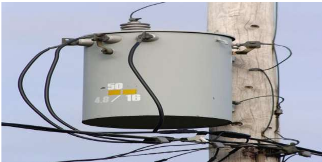
Εικόνα 1-5: Πυλώνας με μετασχηματιστή για μετατροπή σε χαμηλή τάση
