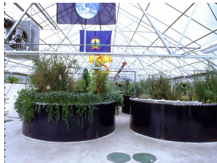
Living machines ή Eco-machines: ένα σύστημα επεξεργασίας λυμάτων με χρήση διάφορων φυτών και μικροοργανισμών του John Todd. Μία από τις μεθόδους που χρησιμοποιούνται στο Mobius Project.
