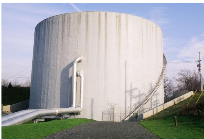
Εικόνα 2.3.4. Thermal Storage Tank
