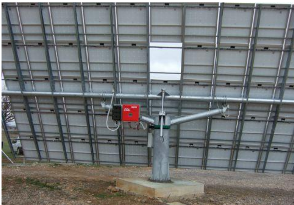
Εικόνα 2.11 Αντιστροφέας στην πίσω πλευρά του συλλέκτη.
