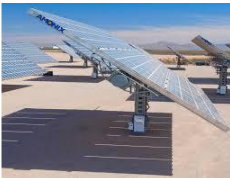
Εικόνα 2.4 Περιστρεφόμενος συλλέκτης ηλιακής ακτινοβολίας
