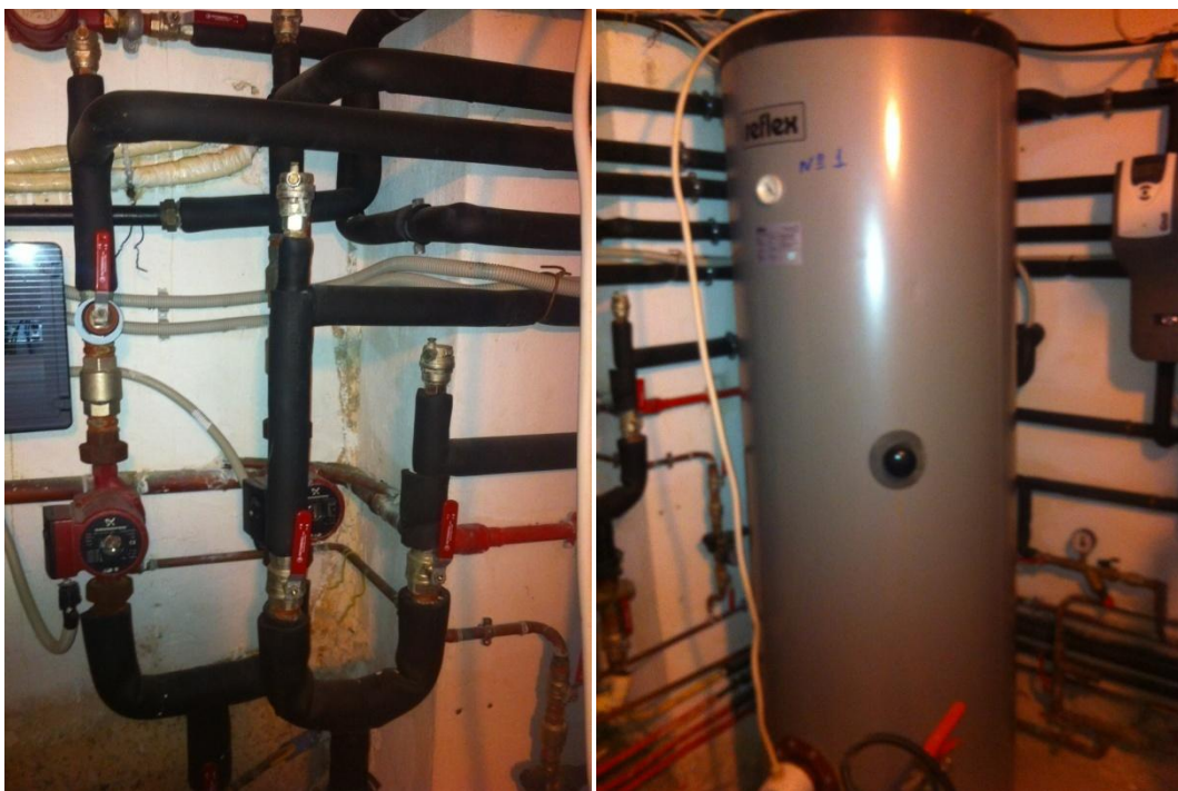
Εικόνα 16 : Εγκαταστάσεις καυστήρα και δικτύου διανομής Ζ.Ν.Χ.
