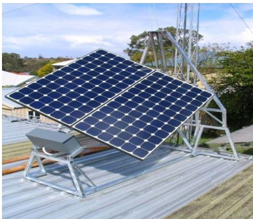
Εικόνα 22: Σύστημα παρακολούθησης της τροχιάς σε 2 άξονες
