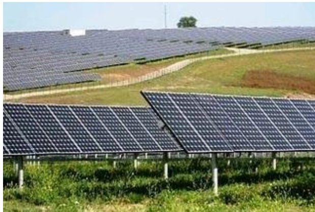
Εικόνα 19: Σύστημα σταθερών συλλεκτών
