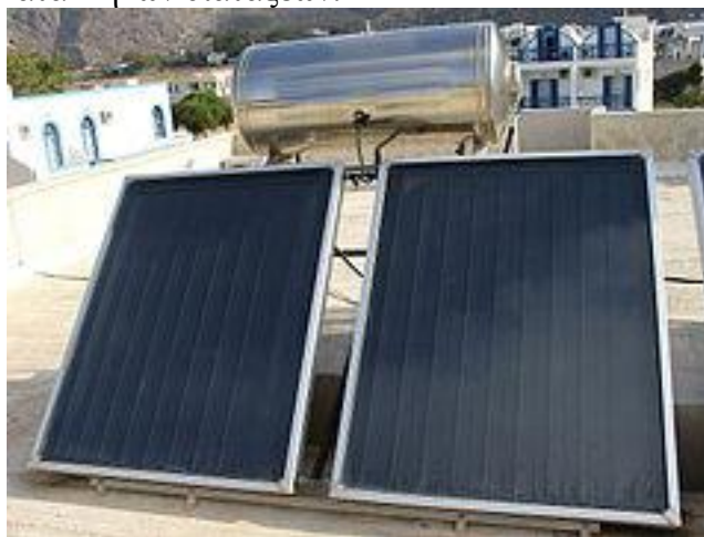
Εικόνα 3.1 Τυπικός ηλιακός συλλέκτης.
