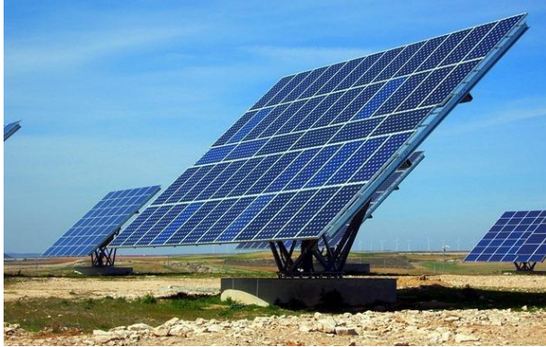
Εικόν 3.5 Φωτοβολταϊκό με σύστημα παρακολούθησης tracker.
