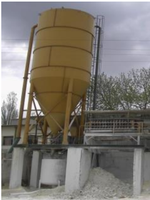
Σχ. 3.7. Μονάδα καθαρισμού νερού με εξαναγκασμένη καθίζηση. Διακρίνεται σωρός στερεού απορρίμματος (μουργκάνα)
