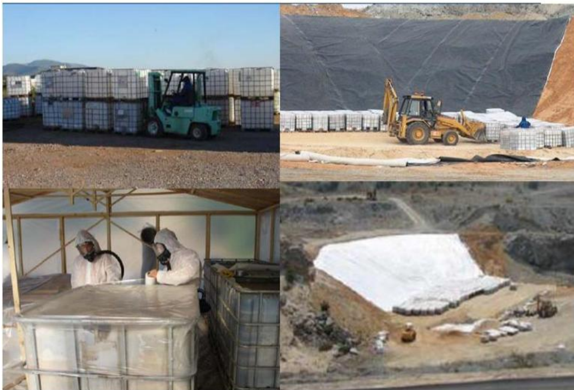
Εικόνα 17: Η απόθεση των αποβλήτων αμιάντου σε ΧΥΤΕΑ (Gidarakos et al., 2008).
