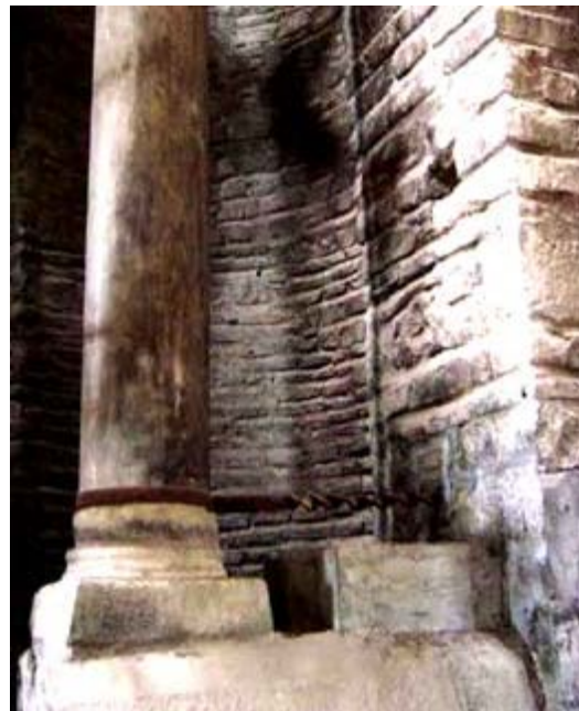
Εικόνα 2.11: Παρηγορήτισσα Άρτας, επέμβαση Ορλάνδου 1960, σιδηρές στεφάνες συγκράτησης, σιδηρά συνδετήρια και ελκυστήρες διαρρηγνύουν τα μαρμάρινα μέλη (Παπασταματίου, 2009) .
