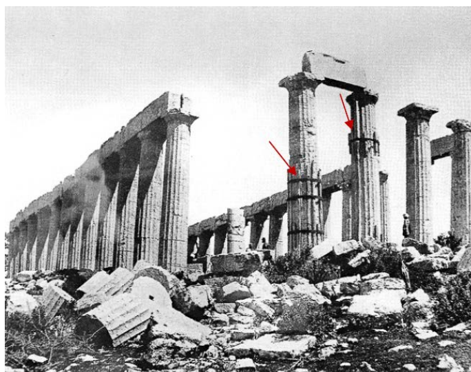
Εικόνα 2.6: Ναός Επικούρειου Απόλλωνα με τις σιδερένιες στεφάνες του 1880 (Παπασταματίου, 2009)
