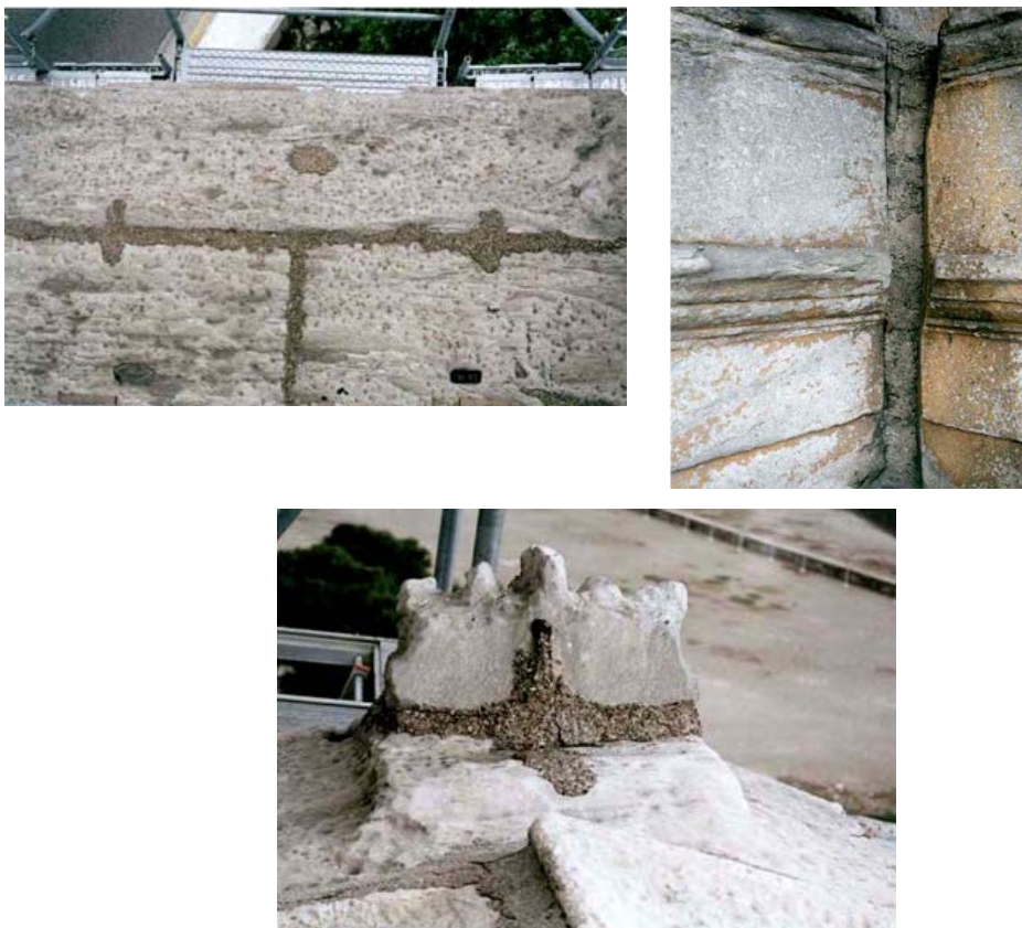
Εικόνα 2.10: Πύλη Αδριανού. Ισχυρά τσιμεντοκονιάματα επικαλύπτουν σιδηρά συνδετήρια και σφραγίζουν αρμούς και κενά (Παπασταματίου, 2009).
