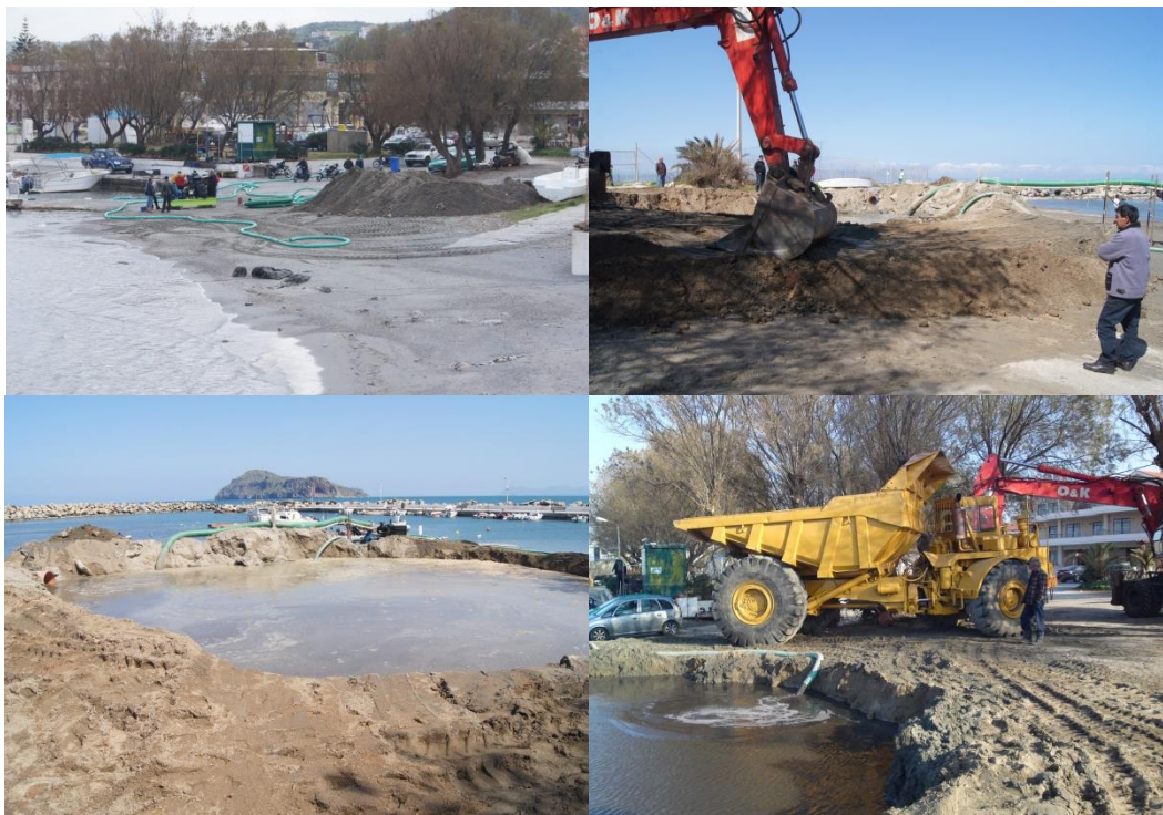
Εικόνα 8.14: Ο χώρος απομάκρυνσης του νερού, συγκέντρωσης, συλλογής, και μεταφόρτωσης του ευκαιριακού υλικού στο λιμάνι του Πλατανιά.
