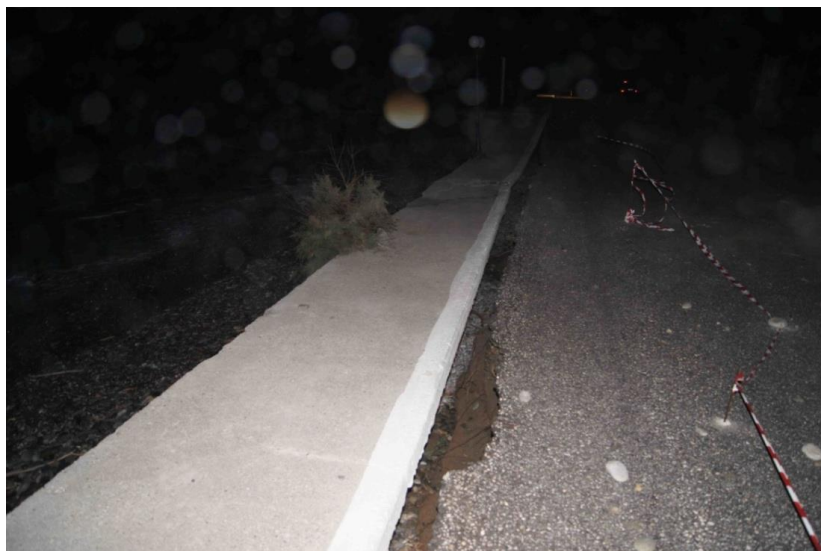
Εικόνα 5.5: Έντονη διάβρωση και κατάρρευση τμήματος του πεζοδρομίου και του δρόμου μετά από κυματική καταιγίδα στις 9/11/2012 στην παραλία Ταυρωνίτη, Χανίων.
