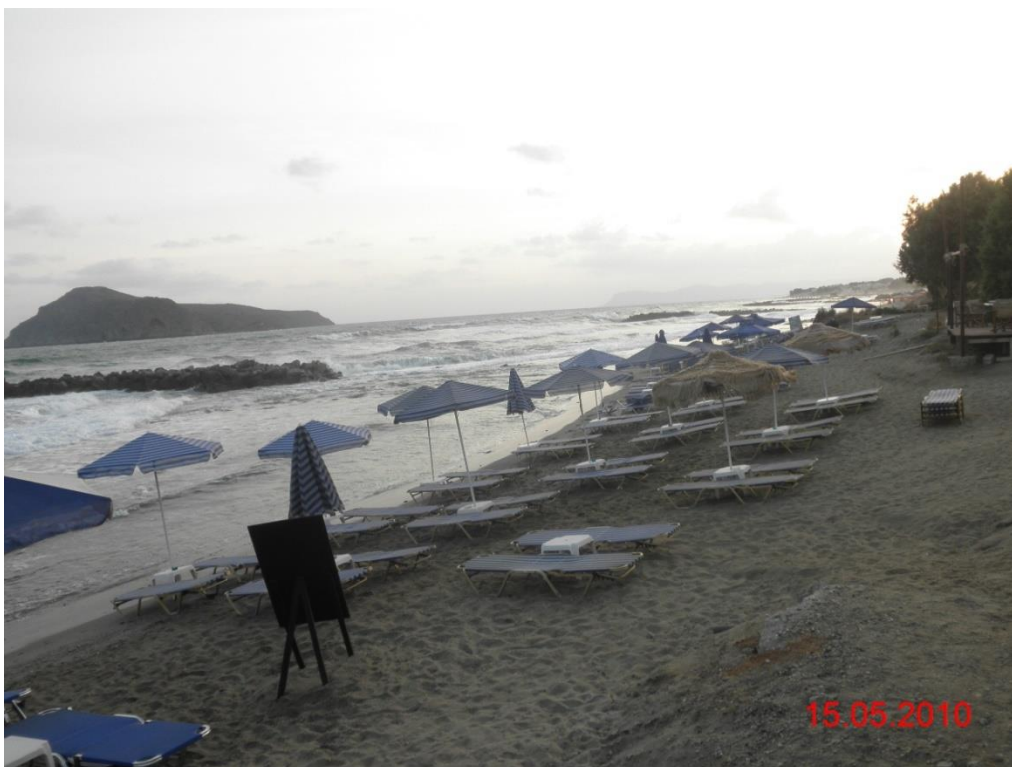
Οι πρόβολοι που τοποθετήθηκαν στην παραλία Πλατανιάς, Χανιά μάλλον δεν έλυσαν το πρόβλημα της διάβρωσης αλλά το επέτειναν.
