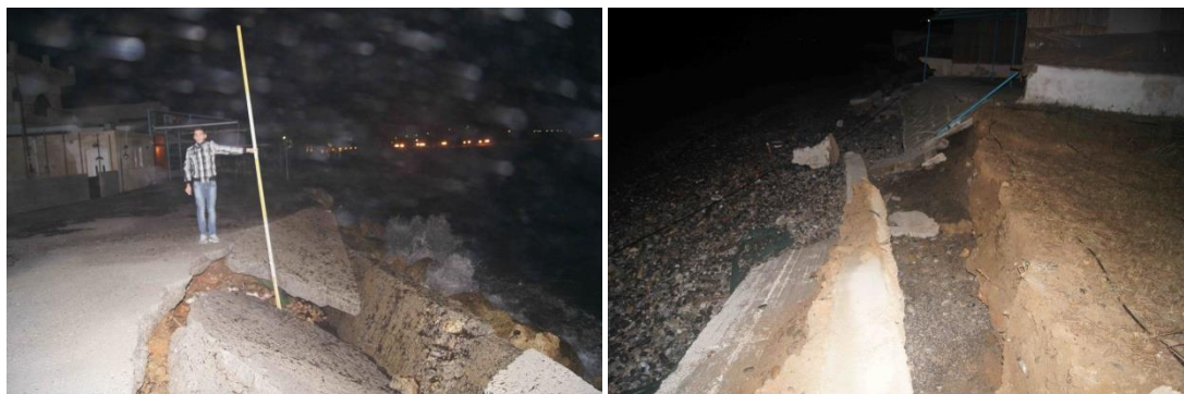
Εικόνα 5.8: Νοέμβριος 2012, αποτελέσματα μιας έντονης κυματικής καταιγίδας στα οχρωματικά έργα (θαλάσσιος τοίχος από ογκόλιθους) της παράκτιας ζώνης του Κολυμβαρίου, Χανιά.
