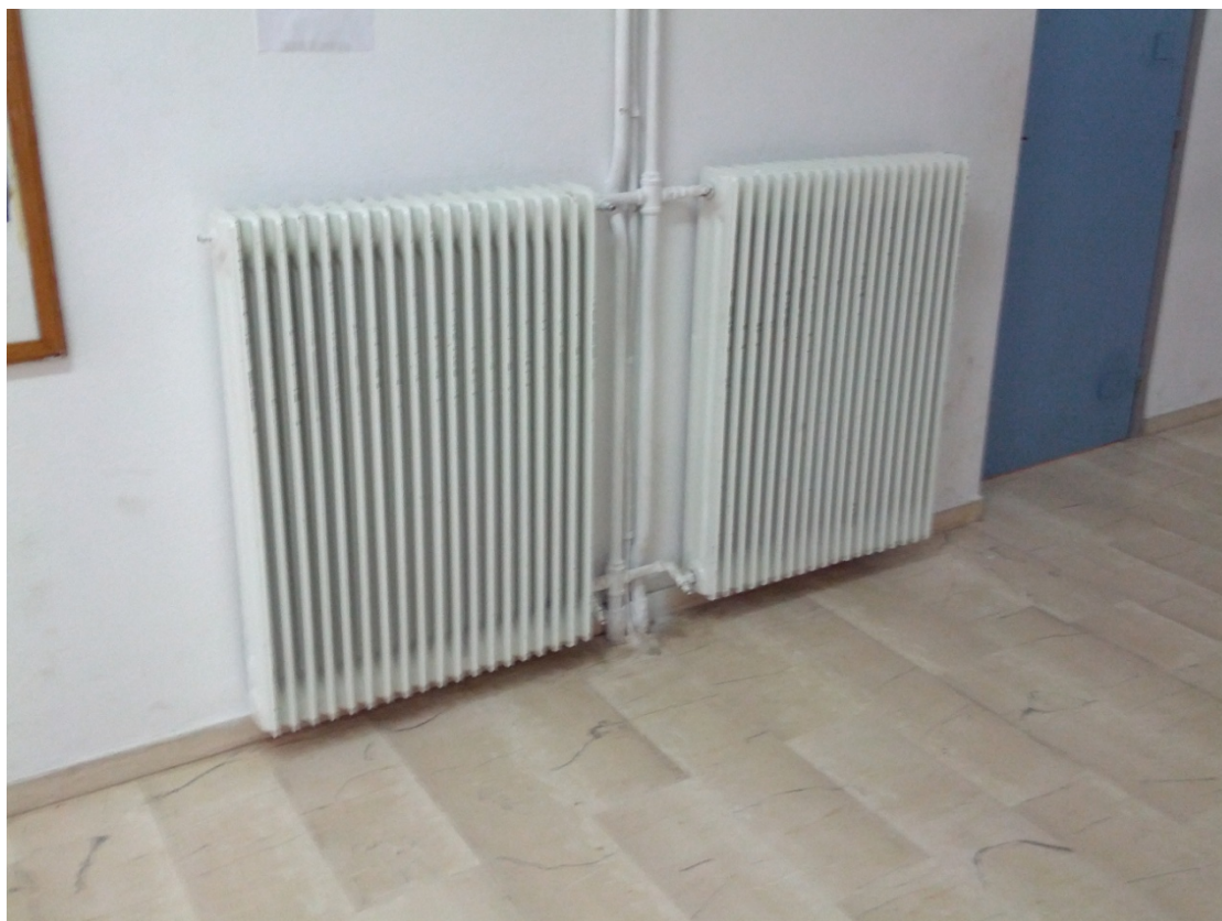
Εικόνα 21: Θερμαντικό σώμα τύπου AKAN σε διάδρομο του σχολείου.
