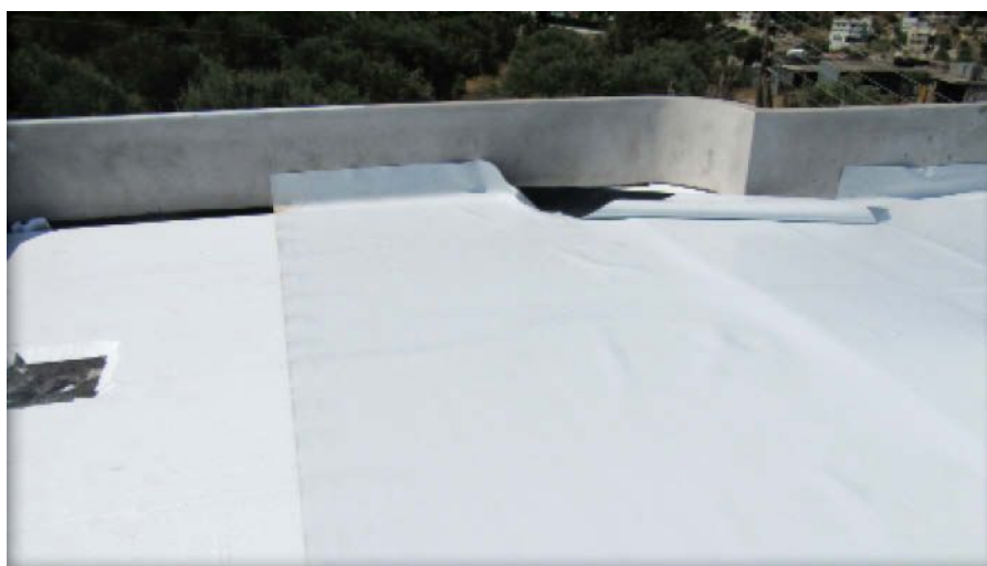
Εικόνα 26: Εφαρμογή εξωτερικής μόνωσης από πολυστερίνη σε οριζόντια οροφή.
