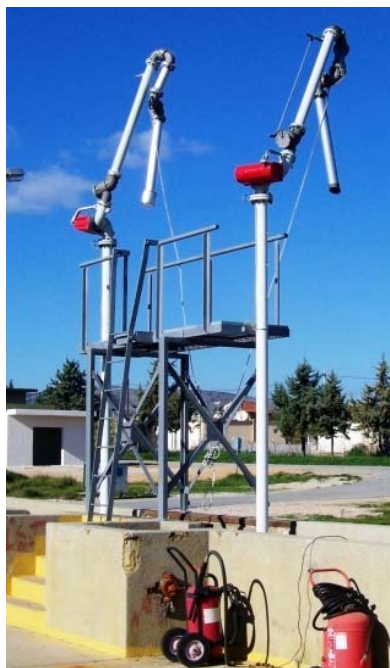
Εικόνα 6: Γεμιστήρια τύπου Top Loading Arm
