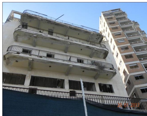
Εικ.110:Διάβρωση του σκυροδέματος
