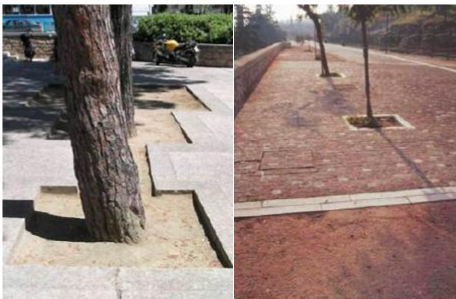
Εικόνα 6: Επίστρωση δρόμων και ελεύθερων επιφανειών με υλικά μειωμένης απορροφητικότητας και αυξημένης υδατοπερατότητας [Πηγή: Καψανάκη Ε. Η περίπτωση της περιοχής του Ψυρρή].
