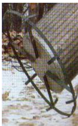
Εικόνα 5.5 : Οδηγός κέντρωσης για ορθότερη τοποθέτηση του φιλτροσωλήνα (πηγή: Driscoll, 1987).
