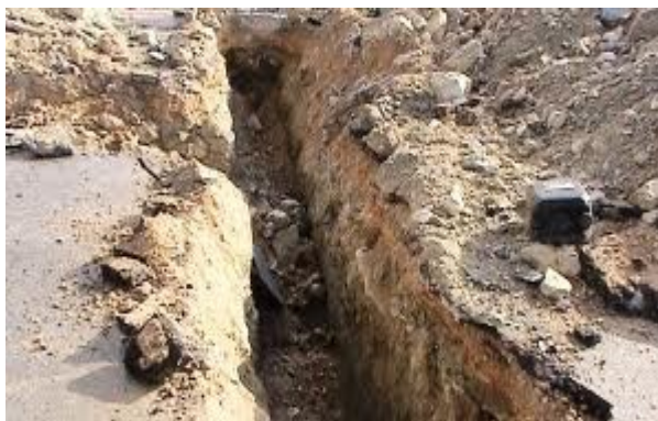
εικόνα(β): όρυγμα μικρού βάθους και μεγάλου μήκους
