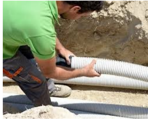
εικόνα(δ): μοντάρισμα σωλήνων εντός χάνδακα
