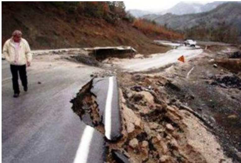
Εικόνα 16 Κατολίσθηση δρόμου στα Ιωάννινα
