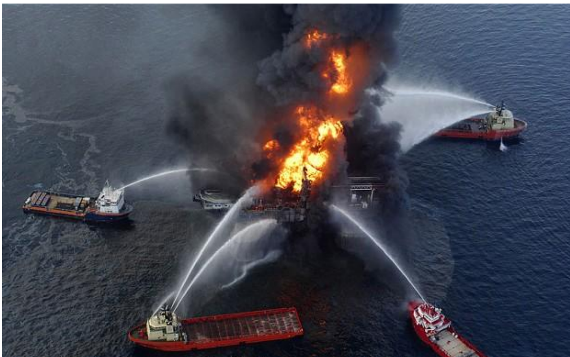
Εικόνα 2.7 (β): Η έκρηξη στη γεώτρηση Macondo της BP η οποία προκλήθηκε από μη ελεγχόμενο "kick" (TELE, 2014)
