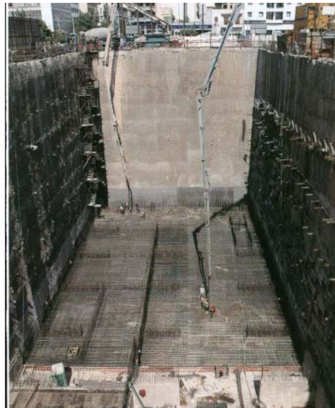
Σχήμα 1.6: Εύκαμπτο πέτασμα με πολλαπλές καθ' ύψος αγκυρώσεις (Μπουκοβάλας 2006).
