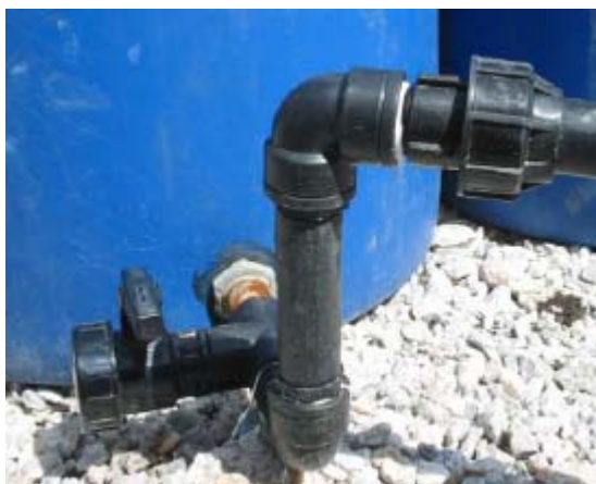
Σχήμα 3.4 – Έξοδος του επεξεργασμένου λύματος από τον Τεχνητό Υγροβιότοπο.
