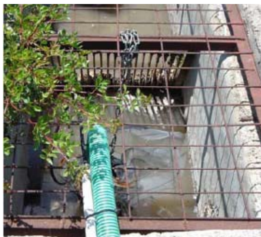
Σχήμα 3.7 – Φρεάτιο δειγματοληψίας
