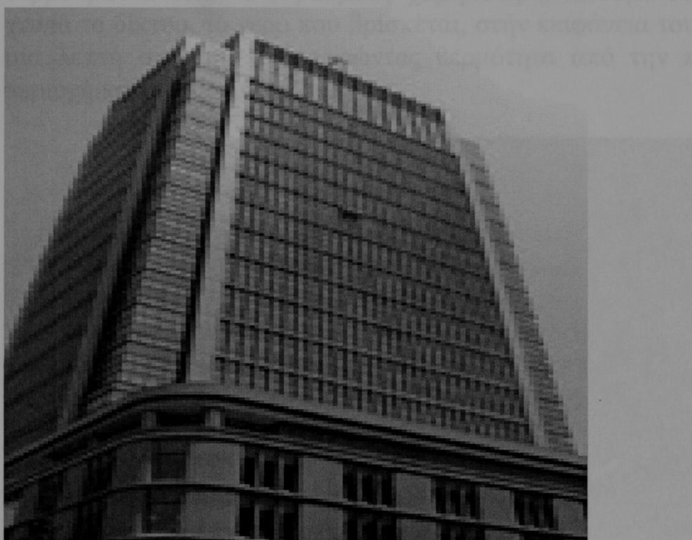
Φωτογραφία 15: Οι τοίχοι του νέου Κτιρίου Marunouchi στο Τόκιο είναι χτισμένο με αυτοκαθαριζόμενα κεραμίδια
