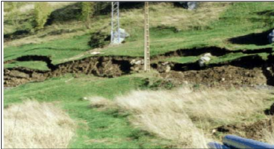
Εικόνα 5.1: Απεικόνιση ασταθειών του εδάφους κατά την εγκατάσταση
