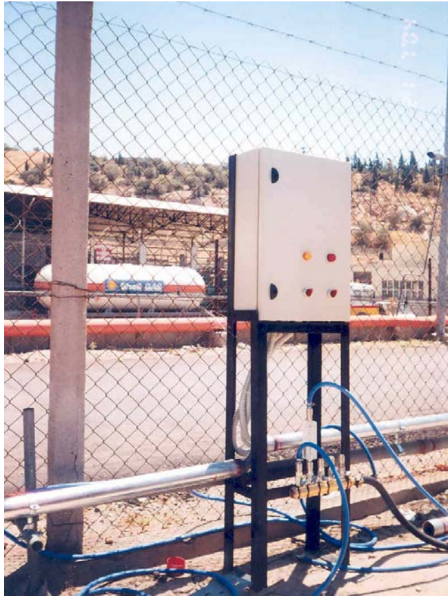
Εικόνα 3: Ο ηλεκτρονικός πίνακας ελέγχου. Στο κάτω μέρος φαίνεται το κολεκτέρ, οι μπλε ελαστικοί σωλήνες που κατανέμουν τον αέρα στα πηγάδια καθώς και το ροόμετρο, με τη βοήθεια του οποίου ελέγχεται η παροχή αέρα σε κάθε ένα από τα πηγάδια της μονάδας.
