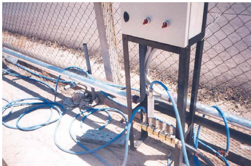
Εικόνα 4: Όψη του κολεκτέρ, των μπλε ελαστικών σωλήνων που κατανέμουν τον αέρα στα πηγάδια και του ροόμετρου.
