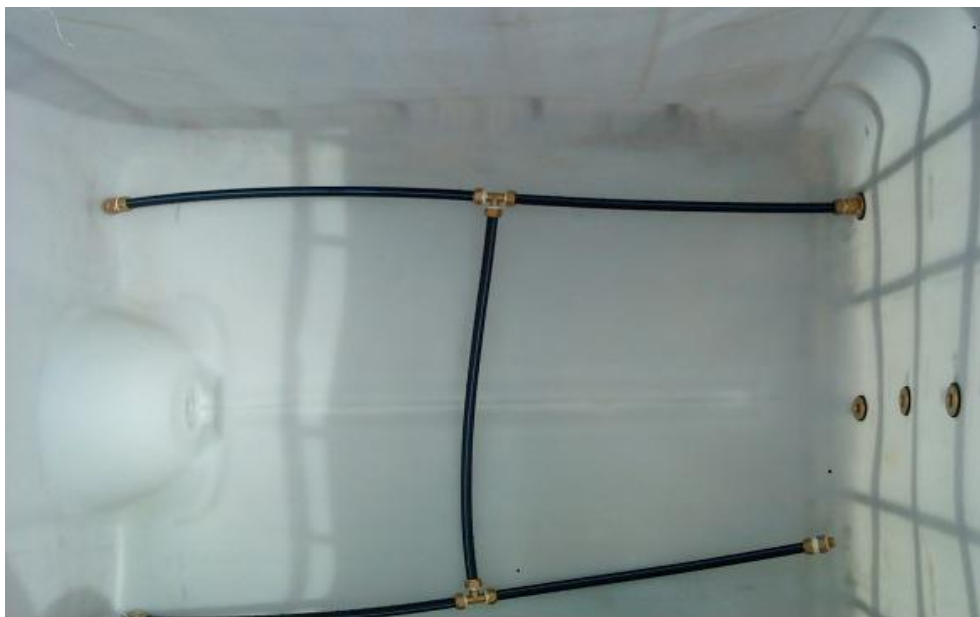
ΕΙΚΟΝΑ 5: ΤΟΠΟΘΕΤΗΣΗ ΤΟΥ ΣΥΣΤΗΜΑΤΟΣ ΑΔΡΕΥΣΗΣ ΣΤΟΝ ΠΥΘΜΕΝΑ ΤΗΣ ΔΕΞΑΜΕΝΗΣ
