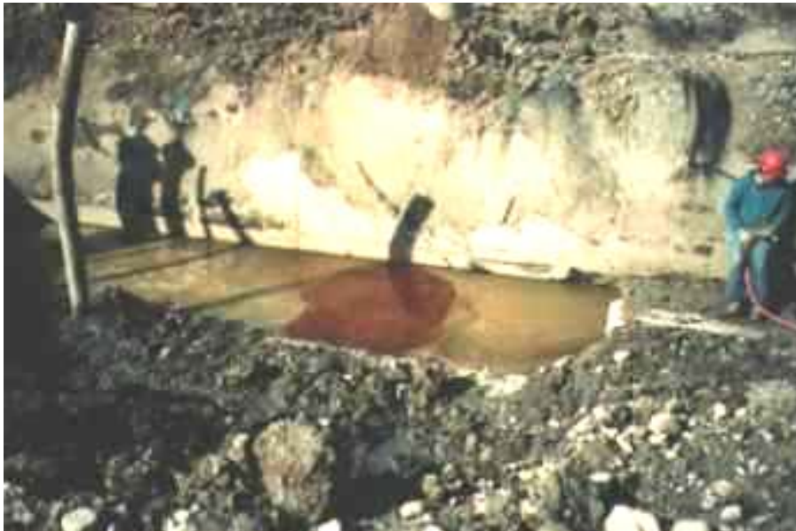
Εικόνα 1.4: Διαρροή η οποία εντοπίζεται από το πορτοκαλί χρώμα που φαίνεται στο νερό (US Army Corps of Engineers, Huntington, District)
