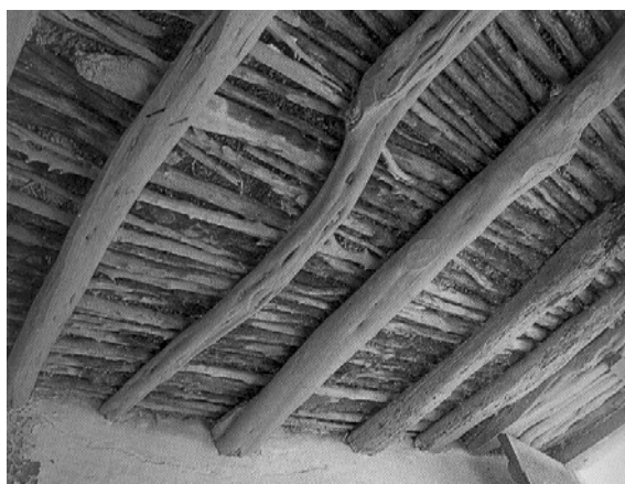
Εικ.37 Στέγη από κορμούς και καλάμια στη Λέρο [11]
