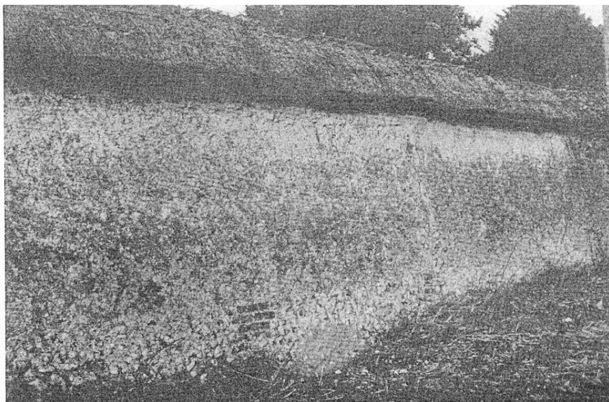
Εικ.16 Τοίχος από χώμα σε βάση από πυρόλιθο και τούβλο
