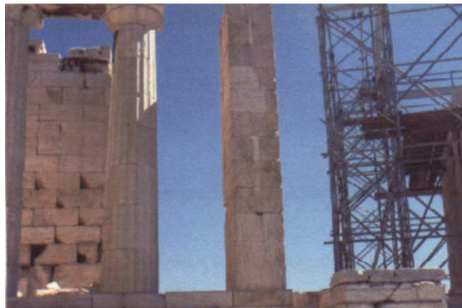
Σχήμα 6.1: Αντικατάσταση ακατάλληλων τεμαχίων μαρμάρου με μάρμαρο Διονύσου στο ναό του Παρθενώνα.
