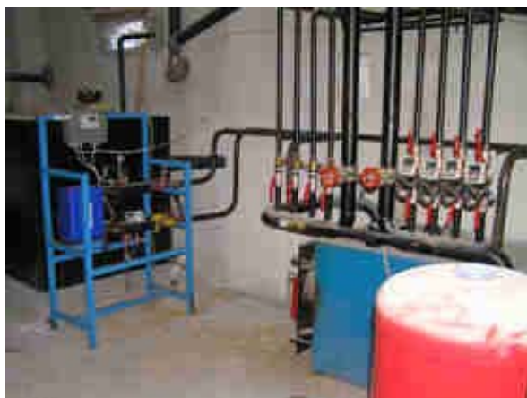
Σχήμα 57: Τυπική εγκατάσταση Θερμικών Υποσταθμών Καταναλωτών δικτύου Τηλεθέρμανσης Αμύνταιου [81]
