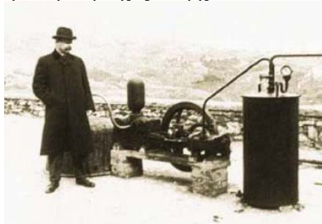
Σχήμα 33: Η μηχανή που χρησιμοποιήθηκε στο Larderello το 1904 κατά την πρώτη πειραματική απόπειρα παραγωγής ηλεκτρικής ενέργειας από γεωθερμικό ατμό. Διακρίνεται επίσης ο εφευρέτης της, πρίγκιπας Piero Ginori Conti. [62]
