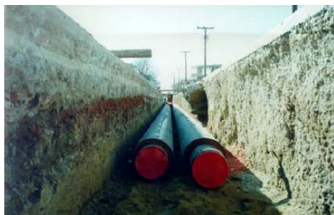
Σχήμα 10: Κλειστό δισωλήνιο σύστημα προμονωμένων αγωγών
