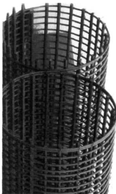
Εικόνα 5.7: Κυκλικοί σπειροειδείς συνδετήρες
