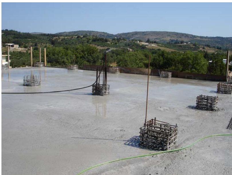
Εικόνα 6.33: Ευθύγραμμη αγκύρωση των διαμήκων ράβδων των υποστυλωμάτων, πάνω από την επιφάνεια της πλάκας πριν τον εγκιβωτισμό τους στο σκυρόδεμα
