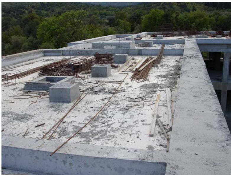
Εικόνα 6.34: Ευθύγραμμη αγκύρωση των διαμήκων ράβδων των υποστυλωμάτων, πάνω από την επιφάνεια της πλάκας μετά τον εγκιβωτισμό τους στο σκυρόδεμα
