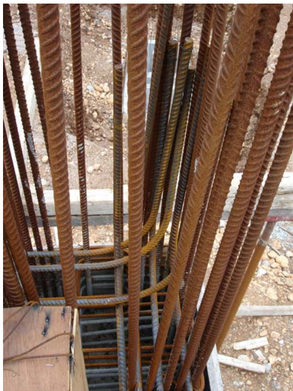
Εικόνα 6.21: Κάτω ράβδοι δοκού που αγκυρώνονται σε γωνιακό υποστύλωμα
