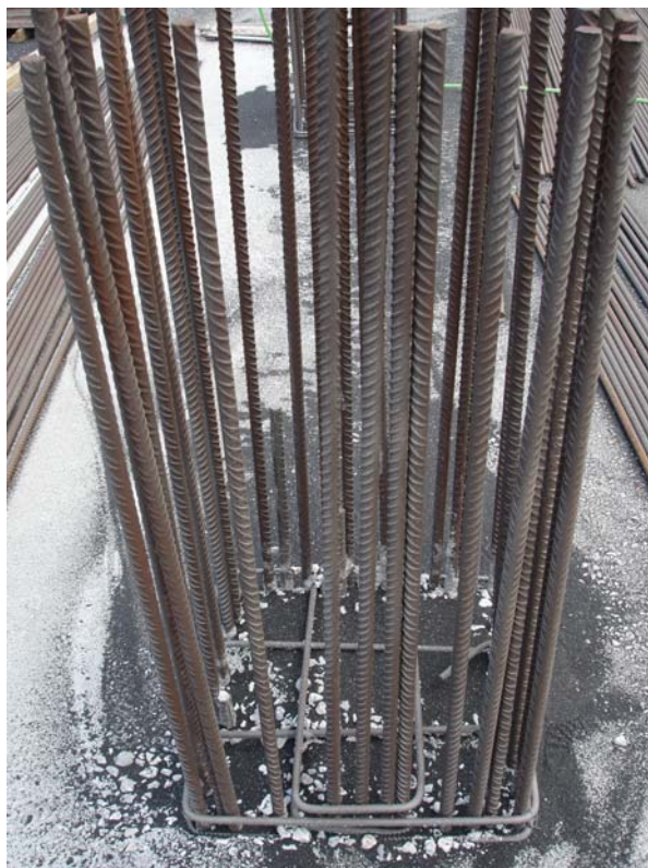
Εικόνα 6.38: Αναμονές υποστυλώματος μετά την αμμοβολή
