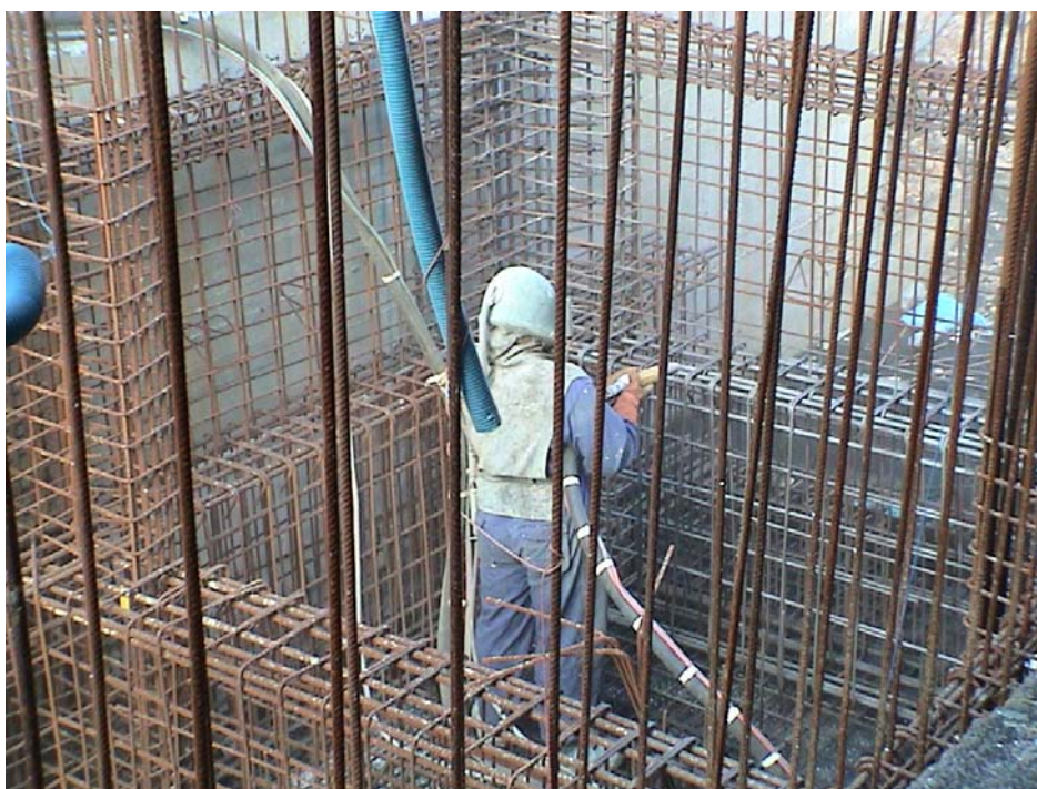
Εικόνα 6.35: Αμμοβολή στη θεμελίωση του Β κτιρίου
