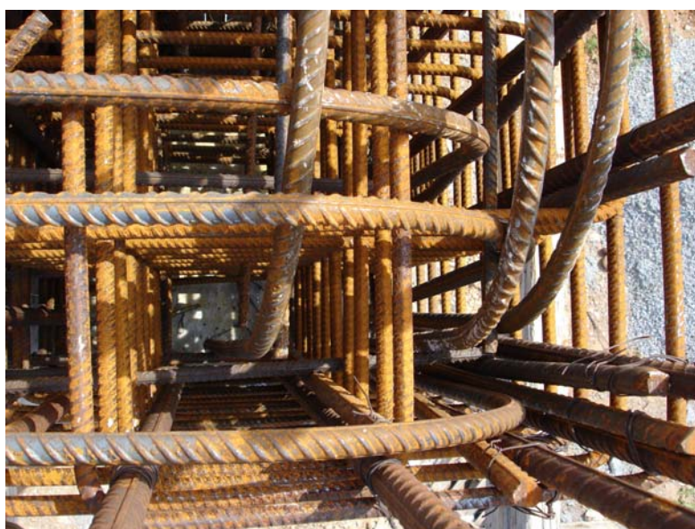
Εικόνα 6.22: Άνω ράβδοι δοκού που αγκυρώνονται σε γωνιακό υποστύλωμα
