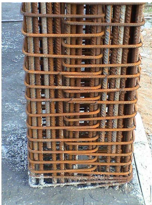
Εικόνα 6.32: Πύκνωση συνδετήρων στην κρίσιμη περιοχή υποστυλώματος
