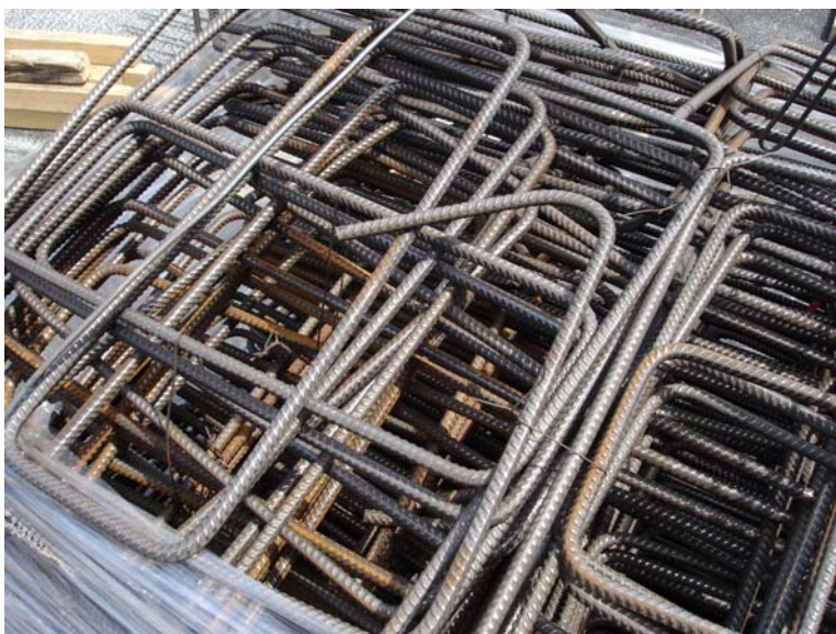
Εικόνα 6.25: Μήκος γάντζου 10Φ σε «θώρακα» διαμέτρου Φ12
