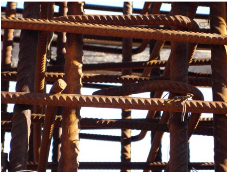
Εικόνα 6.26: Κομμένος «θώρακας» τοποθετημένος σε υποστύλωμα
