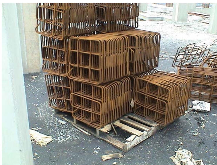
Εικόνα 5.11 Συνεπτυγμένοι «θωράκες» διατομής Φ10 στο εργοτάξιο
