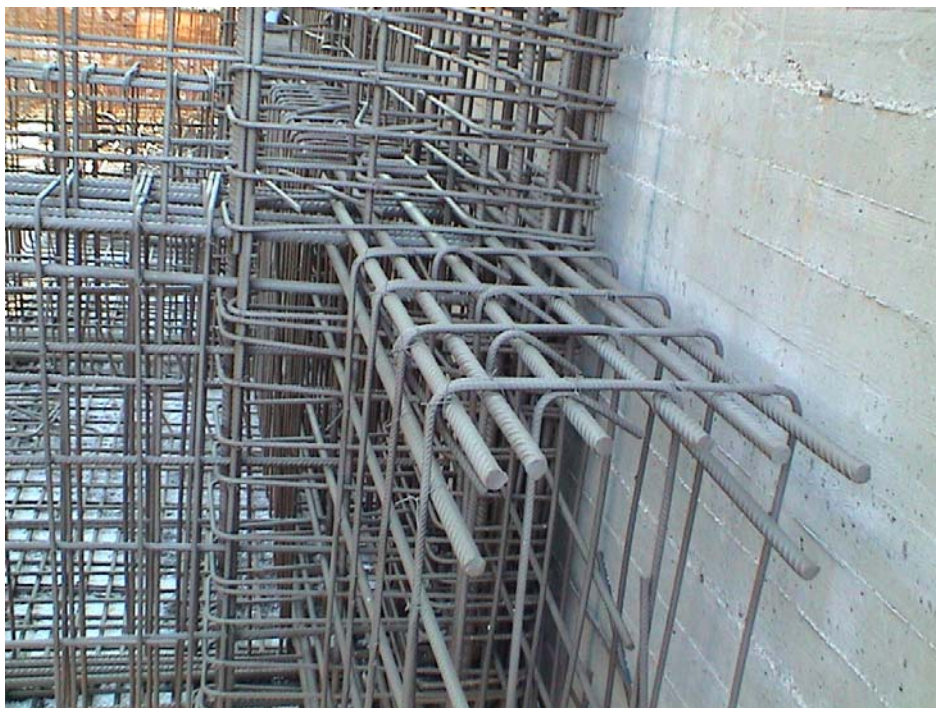
Εικόνα 6.36: Η θεμελίωση του Β κτιρίου μετά την αμμοβολή
