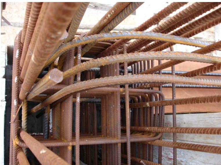
Εικόνα 6.29: Τοποθετημένοι άνω ράβδοι δοκού που αγκυρώνονται σε γωνιακό υποστύλωμα. Φαίνεται καθαρά το μήκος του γάντζου το οποίο καταλήγει χαμηλότερα από την κάτω επιφάνεια της δοκού.
