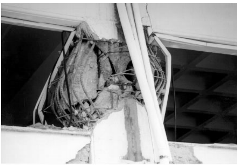
Εικόνα 5.5: Αστοχία εγκάρσιου οπλισμού-Λυγισμός ευθύγραμμων ράβδων
