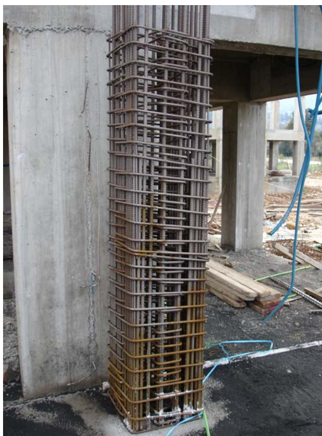
Εικόνα 6.37: Αμμοβολή εν εξελίξη σε υποστήλωμα ισογείου του Ε κτιρίου. Είναι εμφανής η διαφορά της καθαρισμένης από την σκουριασμένη επιφάνεια των ράβδων.
