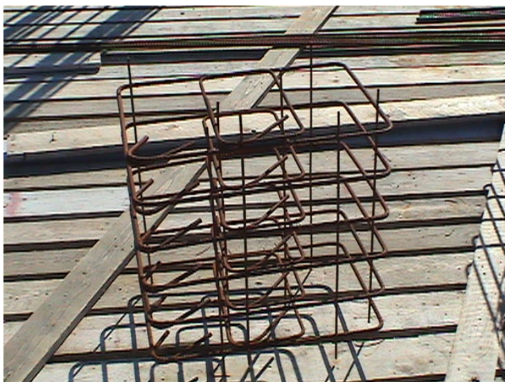
Εικόνα 5.14: Κλωβός συνδετήρων με σύνθετο μονοκόμματο συνδετήρα
