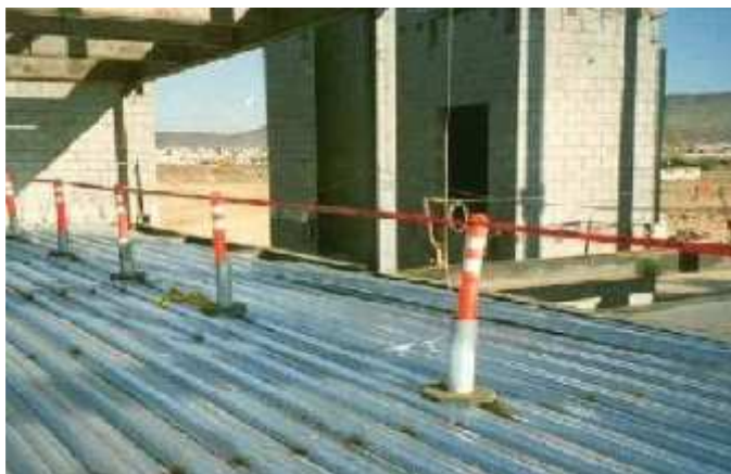
Εικόνα 4.34 Στις στέγες πρέπει να υπάρχουν προστατευτικά κάγκελα
