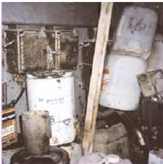
Εικόνα 3.47. Έλλειψη καθαριότητας και ευταξίας στους ηλεκτρικούς πίνακες
