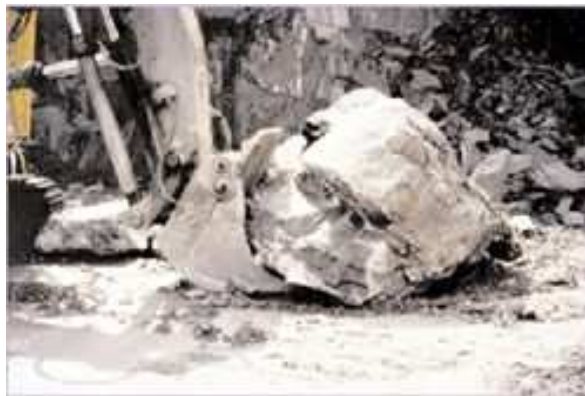
Εικόνα 3.31. Ατύχημα που οφείλεται σε υπέρβαση της ανυψωτικής ικανότητας του εκσκαφέα [26]
