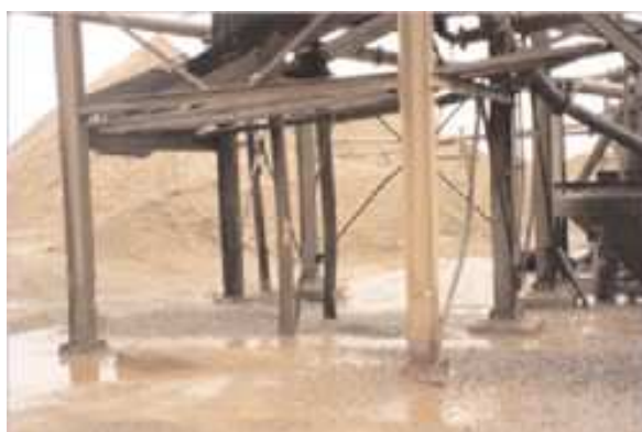
Εικόνα 3.41. Κίνδυνοι σταθερότητας εξαιτίας αυτοσχεδιασμών στις κατασκευές [26]
