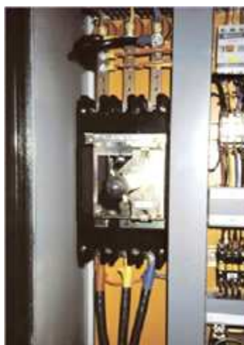
Εικόνα 3.48. Εκτεθειμένος ηλεκτρικός πίνακας με ακάλυπτες επαφές που μπορεί να προκαλέσουν ηλεκτροπληξία κατά το χειρισμό.
