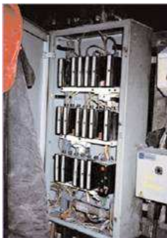
Εικόνα 3.48. Εκτεθειμένος ηλεκτρικός πίνακας με ακάλυπτες επαφές που μπορεί να προκαλέσουν ηλεκτροπληξία κατά το χειρισμό.
