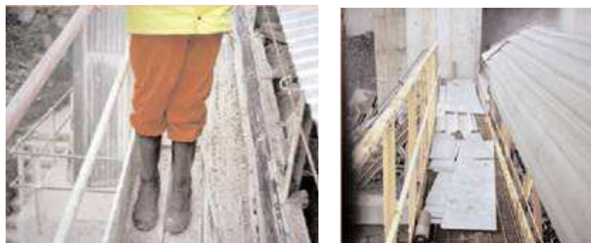
Εικόνα 3.40. Κίνδυνος τραυματισμού εξαιτίας κακοσχεδιασμένων οδεύσεων και έλλειψης ευταξίας (housekeeping) [26]
