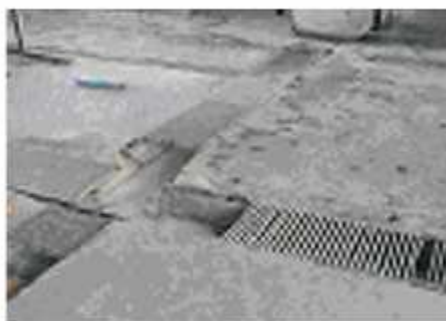
Εικόνα 4.33 Δάπεδο με ακατάλληλα καλύμματα
