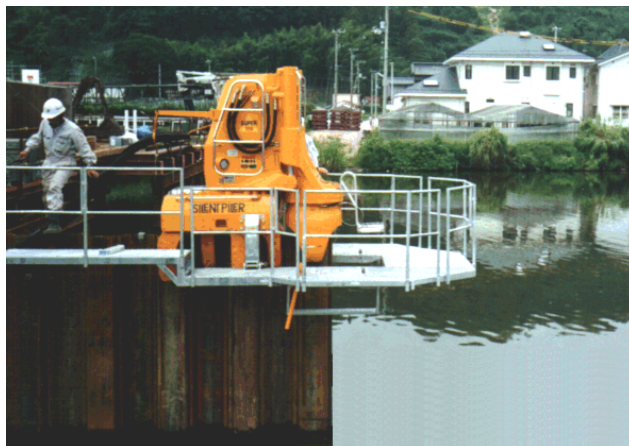
Εικόνα 2-1: Silent Piler («Αθόρυβο» γεωτρύπανο) (Πηγή: www2.eng.cam.ac.uk )
