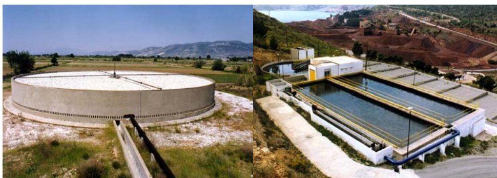
Εικόνα Δ.1. Δεξαμενές πρωτοβάθμιας καθίζησης (κυκλική και ορθογώνια)
