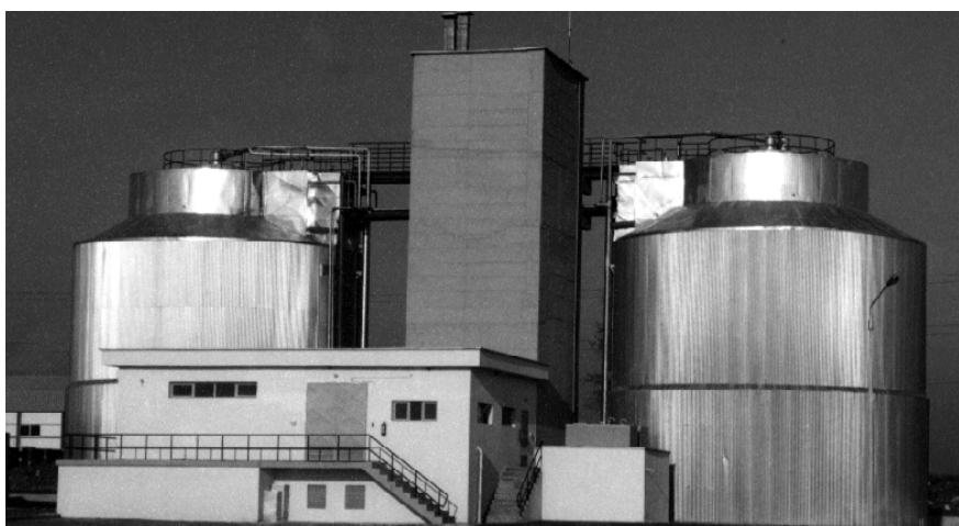
Εικόνα E.10. Μονάδα αναερόβιας χώνευσης ιλύος
