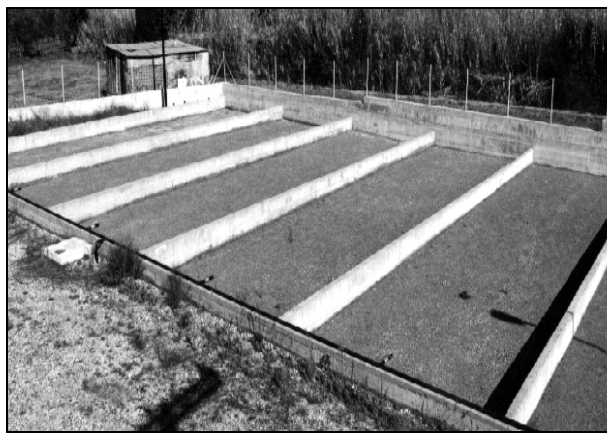
Εικόνα. Ε.3. α) Κλίνες αποξήρανσης ιλύος (Αγγελάκης et al., 2004) β) Σύστημα κλινών ξήρανσης με καλάμια που καθιερώθηκε τον Οκτώβριο του 1996 στη Δανία (S. Nielsen et al.)
