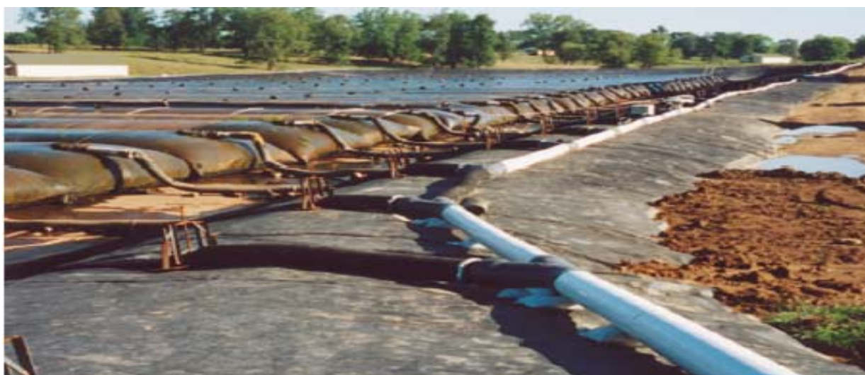
Εικόνα Ε.9. Δίκτυο γαιόσακων αφυδάτωσης σε Κέντρο επεξεργασίας λυμάτων στις ΗΠΑ, Συγκέντρωση στερεών λυματολάσπη 6-9% (GEO ACTIONS, 2005)
