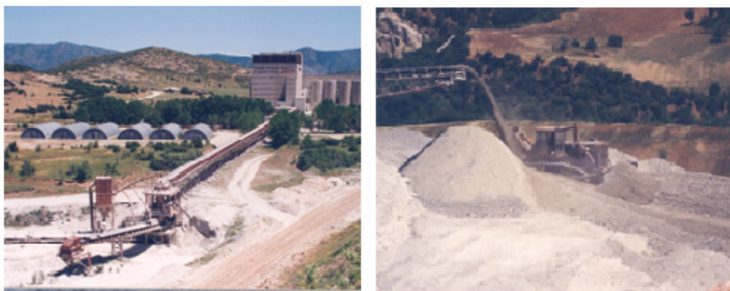
Εικόνα 7.1: Μεταφορά στείρου υλικού και εργασίες διαμόρφωσης στον χώρο των αποθέσεων
