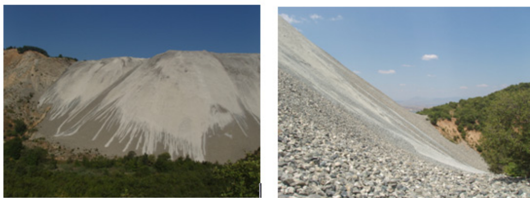
Εικόνα 7.2: Ανομοιογενής κατανομή στείρου υλικού
