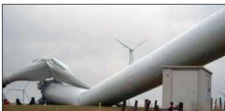
Εικόνα 19: Σπάσιμο πύργου Α/Γ ΠΗΓΗ: www.socme.org
