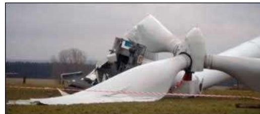
Εικόνα 19: Σπάσιμο πύργου Α/Γ ΠΗΓΗ: www.socme.org
