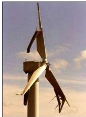
Εικόνα 18: Σπάσιμο πτερυγίων από δυνατό αέρα ΠΗΓΗ: www.socme.org
