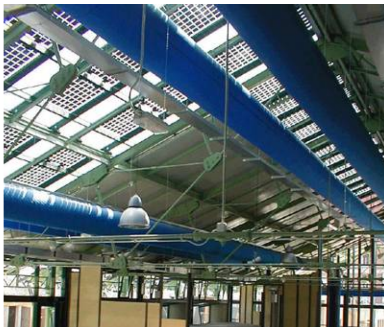
Φωτογραφία 3 : Εσωτερική Όψη του Παιδικού Μουσείου της Ρώμης (Φ/Β στοιχεία ενσωματωμένα στην οροφή του κτιρίου) (πηγή: www.oja-services.nl )
