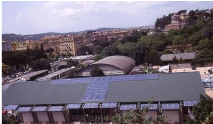
Φωτογραφία 2 : Η οροφή του Παιδικού Μουσείου της Ρώμης (Φ/Β στοιχεία ενσωματωμένα στην οροφή του κτιρίου)
