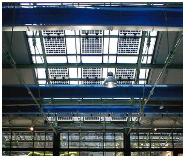
Φωτογραφία 4 : Εσωτερική Όψη του Παιδικού Μουσείου της Ρώμης (Φ/Β στοιχεία ενσωματωμένα στην οροφή του κτιρίου) (πηγή: www.oja-services.nl )
