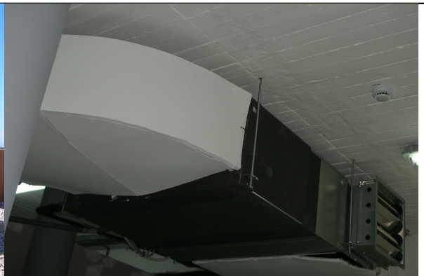
β: Στο υπόγειο βρίσκεται μια εσωτερική μονάδα για την ανακυκλοφορία του αέρα στο κτίριο
