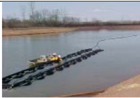
Σχήμα 3.5: Εναλλάκτες θερμότητας στην επιφάνεια της λίμνης, λίγο πριν βυθιστούν.
