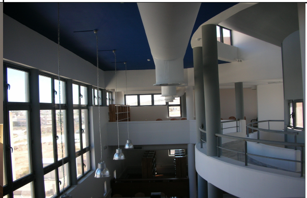
δ: Τμήμα της εσωτερικής οροφής του κτιρίου στο οποίο φαίνεται το σύστημα διανομής του φρέσκου αέρα από τις άσπρες σωληνώσεις
