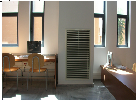
γ: Σύστημα απορρόφησης αέρα από το αναγνωστήριο
