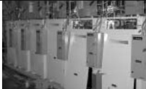
Σχήμα 3.7: Το σύστημα των 14 αντλιών θερμότητας για τους κοινόχρηστους χώρους
