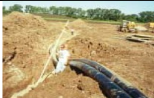
Σχήμα 3.6: Οι κύριοι αγωγοί τροφοδοσίας από και προς το σχολικό κτίριο.
