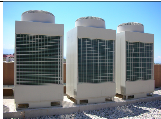
α: Στην οροφή του κτιρίου βρίσκονται οι τρεις εξωτερικές συμβατικές μονάδες κλιματισμού για τη θέρμανση/ψύξη του αέρα στο κτίριο
