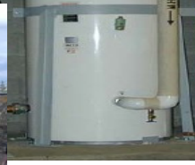
Σχήμα 3.17: Μια αντλία θερμότητας νερού-νερού 10-tons, αντλεί θερμότητα από τον υπόγειο βρόχο και παρέχει ζεστό νερό (50 °C) στα ντους και όπου αλλού χρειαστεί.
