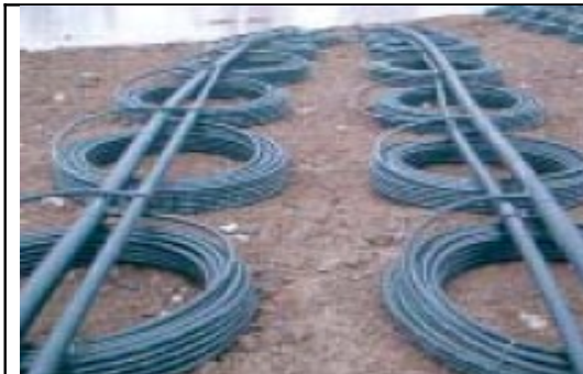
Σχήμα 3.4: Σπειροειδείς διατάξεις εναλλακτών θερμότητας στην όχθη της λίμνης.
