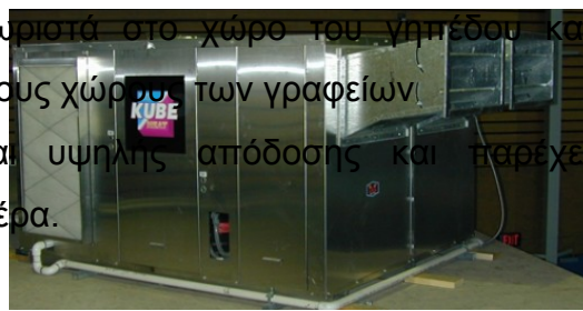
Σχήμα 3.15: Η αφύγρανση, ο κλιματισμός και η θέρμανση στο παγοδρόμιο παρέχονται μέσω μιας αντλίας θερμότητας 20-tons. Ο χώρος του γηπέδου μπορεί να ψύχεται ή να θερμαίνεται απορρίπτοντας ή αντλώντας αντίστοιχα θερμότητα από τον υπόγειο βρόχο.
